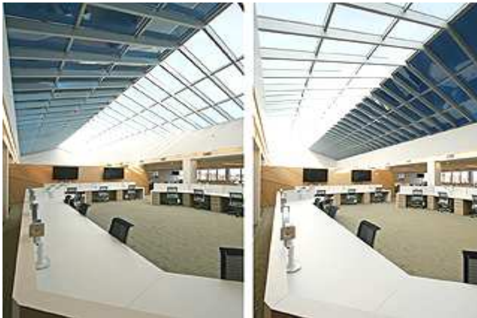
Εικόνα 2.6 Παράθυρα της Sage Electrochromics με ηλεκτροχρωμικό γυαλί που μπορούν να χρωματιστούν σε λίγα λεπτά με το πάτημα ενός κουμπιού. Το κτίριο αυτό στο Γκρήνουιτς, Conn, δείχνει πόσο διαφορετικά μπορούν να χρωματιστούν τα παράθυρα σε διαφορετικές χρονικές στιγμές. [16]
