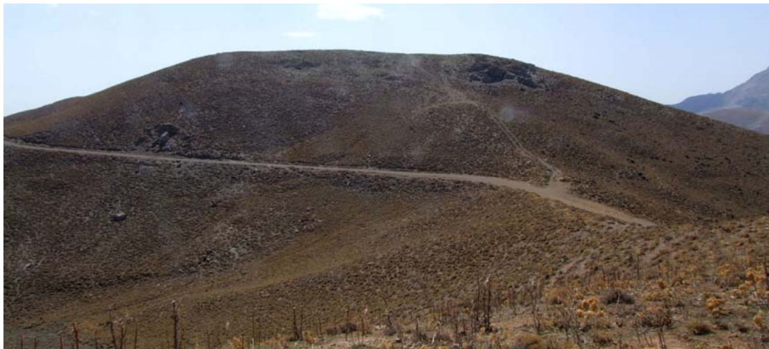
Φωτογραφία Φ.1: Θέση εγκατάστασης των ανεμογεννητριών 11 και 12.
