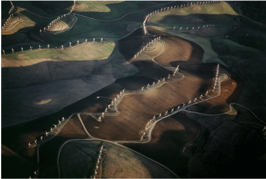
Εικόνα 2.1: Αεροφωτογραφία του αιολικού πάρκου στο Άλταμοντ στην Καλιφόρνια.
