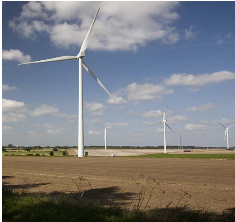
Εικόνα 4.1: Ανεμογεννήτριες Vestas V90 στο North Pickenham της Αγγλίας.
