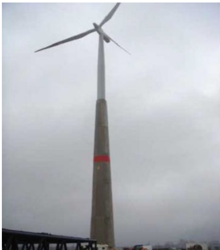
Εικόνα 2:Υβριδικός πυλώνας σκυροδέματος/χάλυβα
