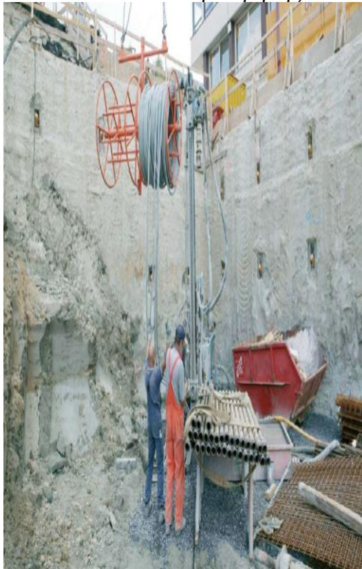
Εικόνα 5 (τοποθέτηση Γεωεναλλάκτη)
