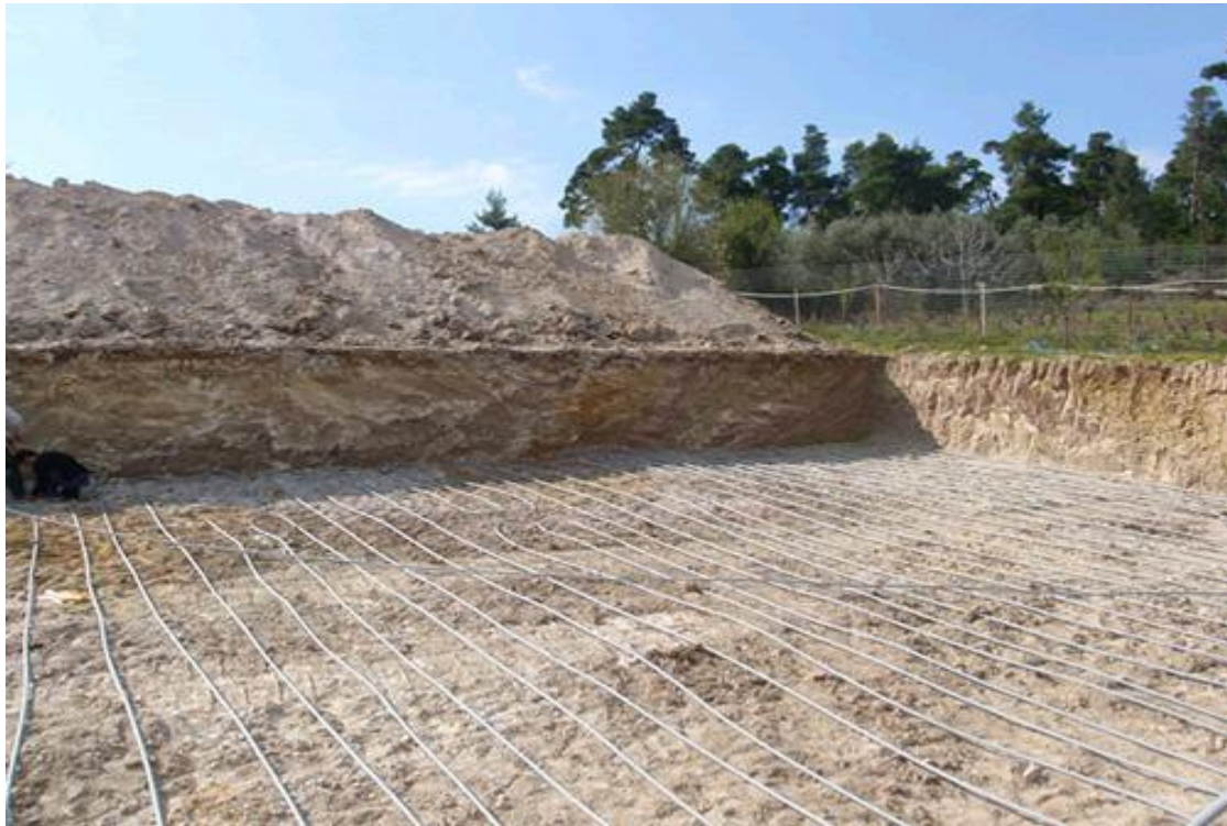
ΕΙΚΟΝΑ 7: Εκσκαφή μορφής ολικής απομάκρυνσης εδάφους και πολλαπλές Σωληνώσεις
