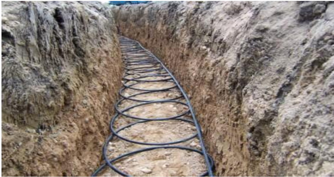
ΕΙΚΟΝΑ 10 : Εκσκαφή μορφής ορύγματος και σπειροειδείς σωληνώσεις
