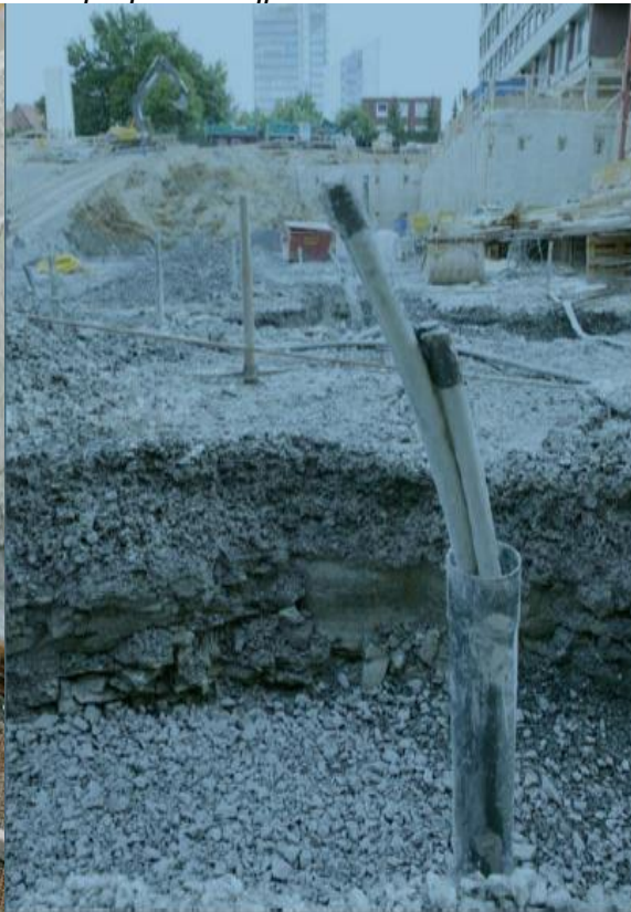
Εικόνα 6 (Γεωεναλλάκτης)
