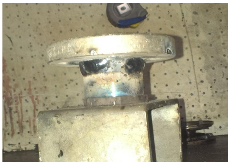
Εικόνα 59: Ηλεκτροσυγκόλληση χαλύβδινου τμήματος στην βιδωτή φλάντζα
