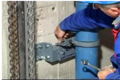
Εικόνα 8 Στήριξη του εμβόλου με τη βοήθεια του στηρίγματος και του ειδικού δακτυλίου
