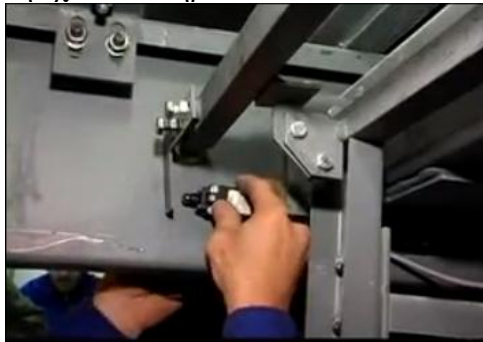
Εικόνα 15:Βίδωμα του contact της αρπάγης έτσι ώστε να εφάπτεται με το λαμάκι της ενεργοποίησης.
