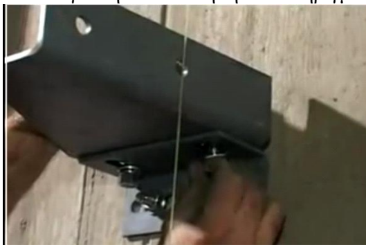
Εικόνα 3: Τοποθέτηση γωνιακού στηρίγματος των οδηγών.
