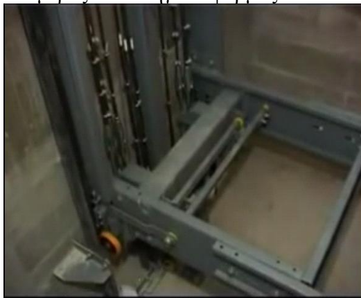
Εικόνα 12: Τοποθέτηση πλαισίου.
