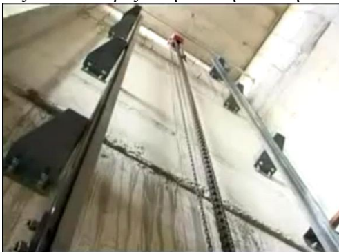
Εικόνα 5: Τοποθέτηση των οδηγών.
