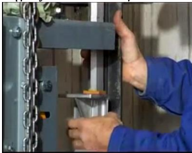
Εικόνα 11: Προσαρμογή των ειδικών ολισθητήρων (παπουτσάκια) επάνω στην τροχαλία και στους οδηγούς.
