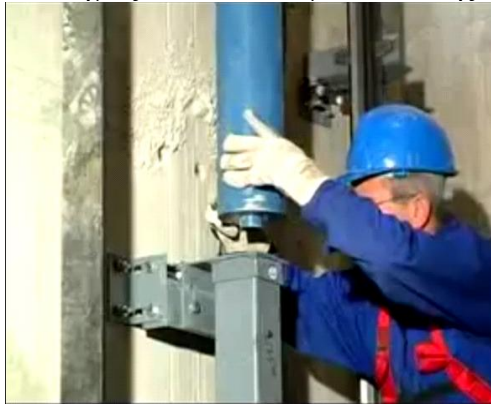
Εικόνα 7: Τοποθέτηση εμβόλου επάνω στον κολοδοκό.
