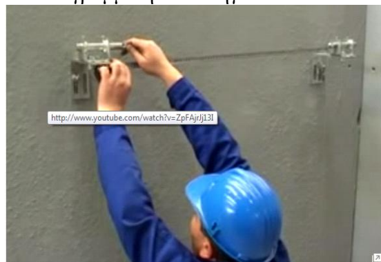
Εικόνα 2: Τοποθέτηση των βάσεων των ραμμάτων.
