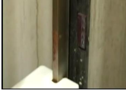
Εικόνα 14:Τοποθέτηση ειδικών μαγνητών επάνω στους οδηγούς.
