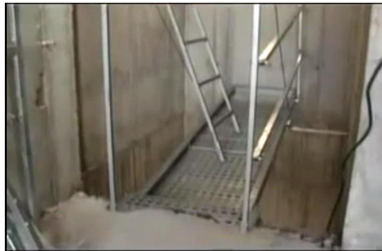
Εικόνα 1: Τοποθέτηση πλατφόρμας μέσα στο φρεάτιο.
