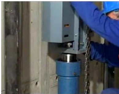
Εικόνα 10: Τοποθέτηση τροχαλίας επάνω στο έμβολο.
