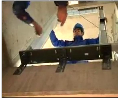
Εικόνα 13:Τοποθέτηση θύρας ορόφου.
