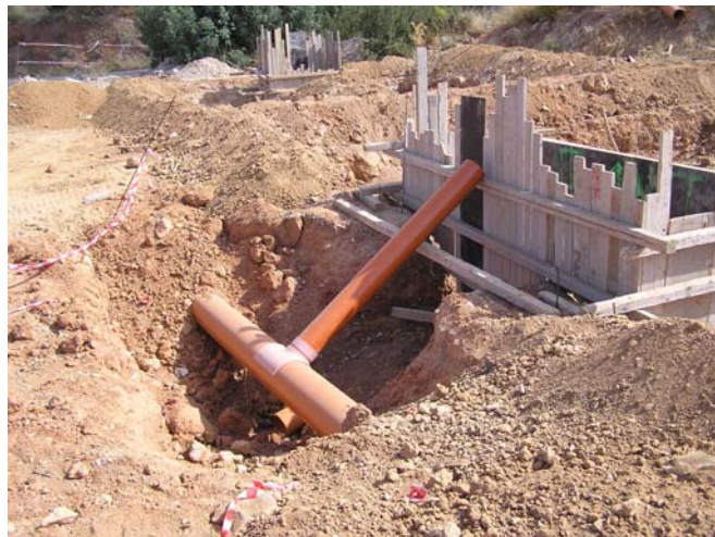
Φώτο 3.8 Σύνδεση συστήματος υπερχειλίσης με ζεύγος υγροβιότοπων
