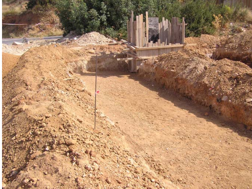
Φώτο 3.11 Δημιουργία αναχώματος γύρω από τους υδροβιότοπους ελεύθερης επιφάνειας
