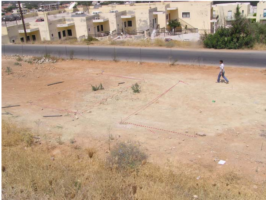
Φώτο 3.3 Διαδικασία χάραξης εκσκαφών
