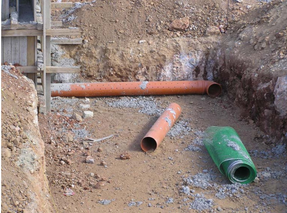
Φώτο 3.19 Τοποθέτηση σωλήνων (διάτρητοι) εκροής υγροβιότοπων
