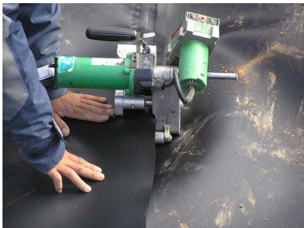
Φώτο 3.23 Ειδικό εξάρτημα συγκόλλησης μεμβρανών
