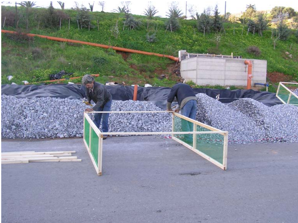
Φώτο 3.26 Κατασκευή τεχνητού καλουπιού για τον διαχωρισμό των υλικών στους υγροβιότοπους υπό επιφανειακής ροής
