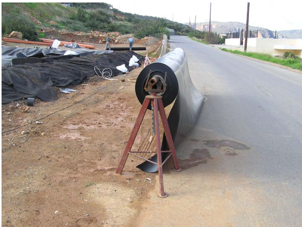
Φώτο 3.22 Μembrάνη πριν την τοποθέτηση της
