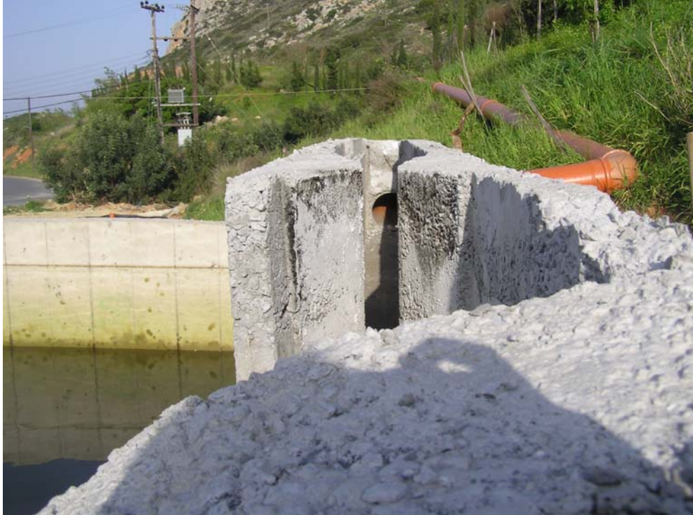
Φώτο 3.17 Ογκομετρητής υδάτων Parshal
