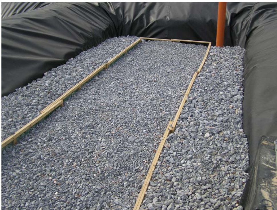
Φώτο 3.28 Ολοκλήρωση πλήρωσης υγροβιότοπων υπό επιφανειακής ροής χωρίς την στρώση των 10 mm
