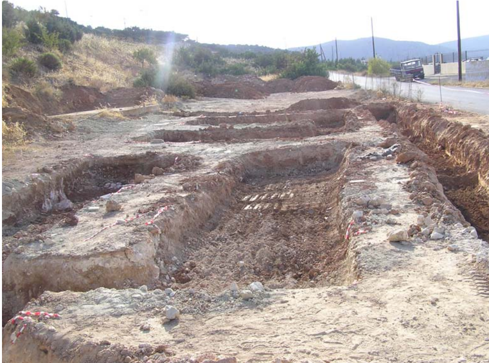
Φότο 3.6 Ολοκλήρωση εργασίας μηχανημάτων
