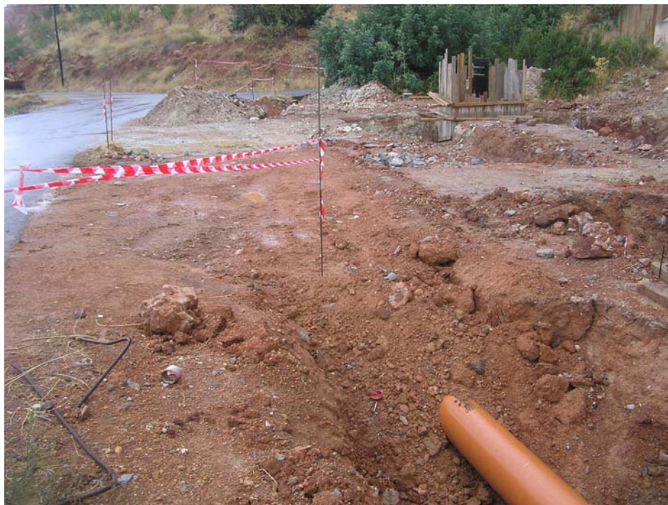
Φώτο 3.13 Επιχωμάτωση συστήματος υπερχείλισης
