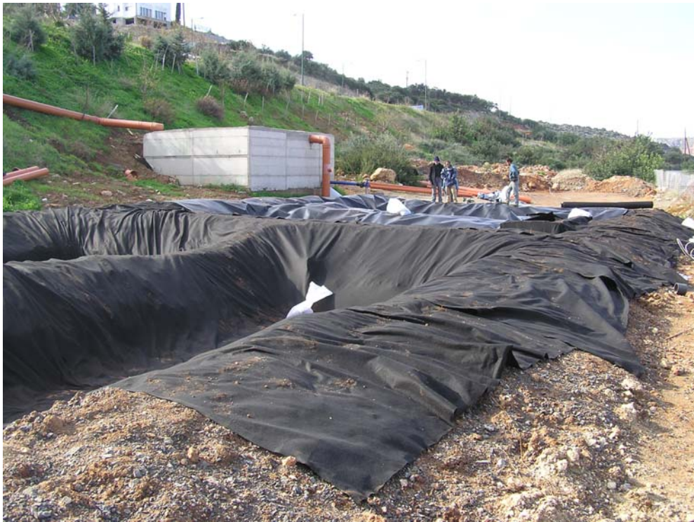
Φώτο 3.24 Τοποθέτηση γεωφάσματος-μεμβράνης
