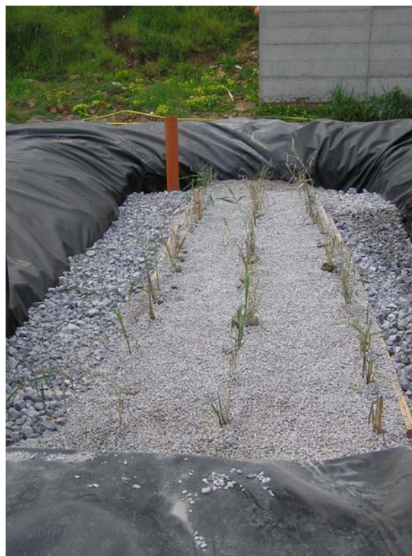
Φώτο 3.33 Ολοκλήρωση φύτευσης υγροβιότοπων υπό επιφανειακής ροής και πλήρωσης αυτών με χαλίκι διαστάσεων 10 mm
