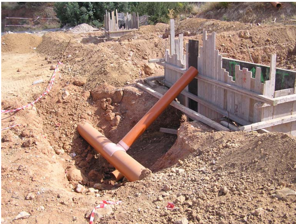
Φώτο 3.18 Ξυλότυπος & σιδηρός οπλισμός φρεατίων εκροής υγροβιότοπων
