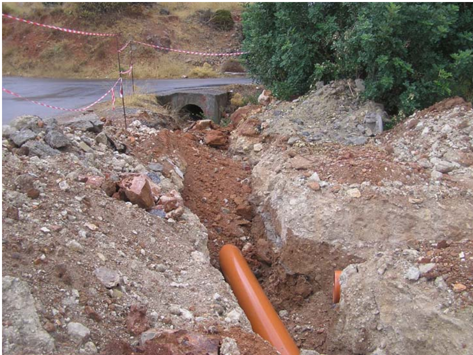
Φώτο3.10 Σύνδεση συστήματος υπερχειλίσης με τεχνικό αγωγό
