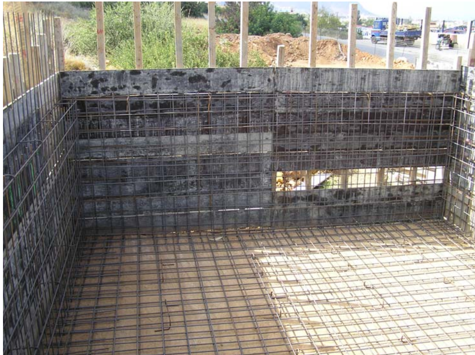
Φώτο 3.16 Ξυλότυπος & σιδηρός οπλισμός δεξαμενής προσωρινής αποθήκευσης
