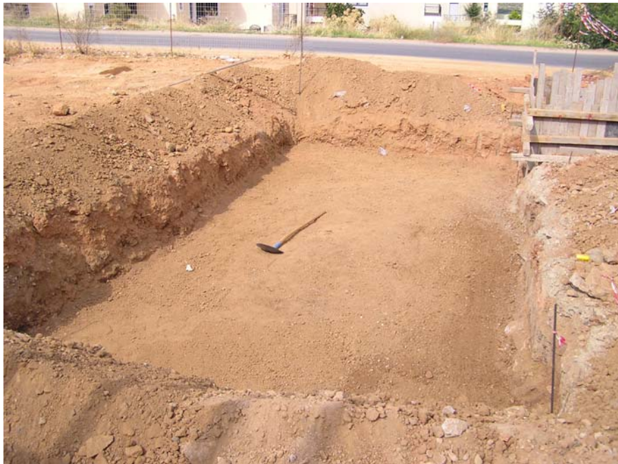
Φώτο 3.12 Δημιουργία αναχώματος γύρω από τους υδροβιότοπους υπό επιφανειακής ροής
