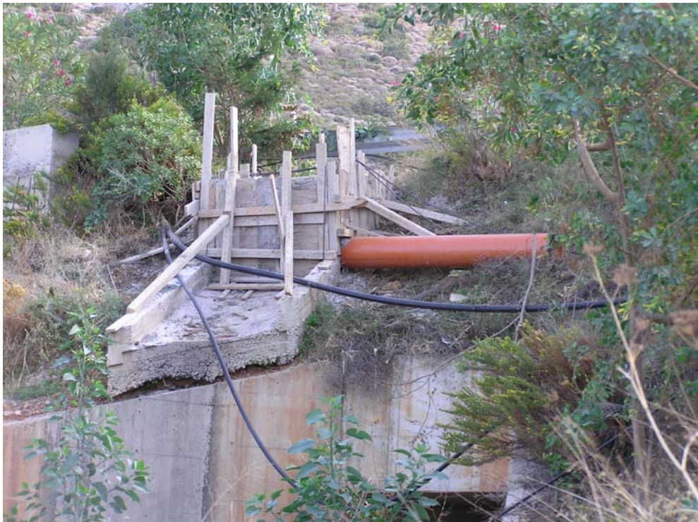
Φώτο 3.21 Ξυλότυπος & σιδηρός σπλισμός φρεατίου εισροής στον τεχνικό εκροής της Εθνικής Οδού
