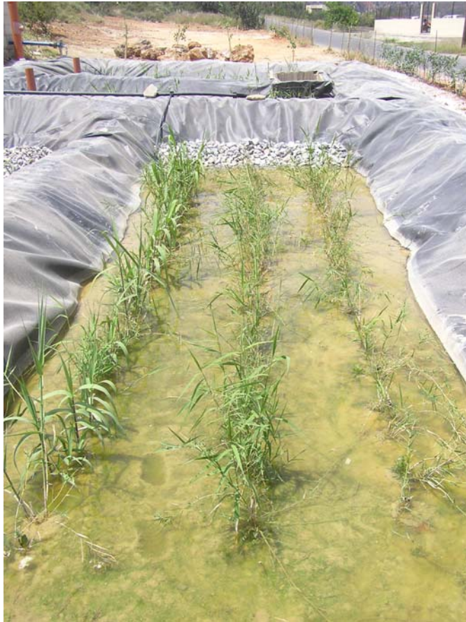
Φώτο 3.35 Ολοκλήρωση φύτευσης υγροβιότοπων επιφανειακής ή ελεύθερης ροής
