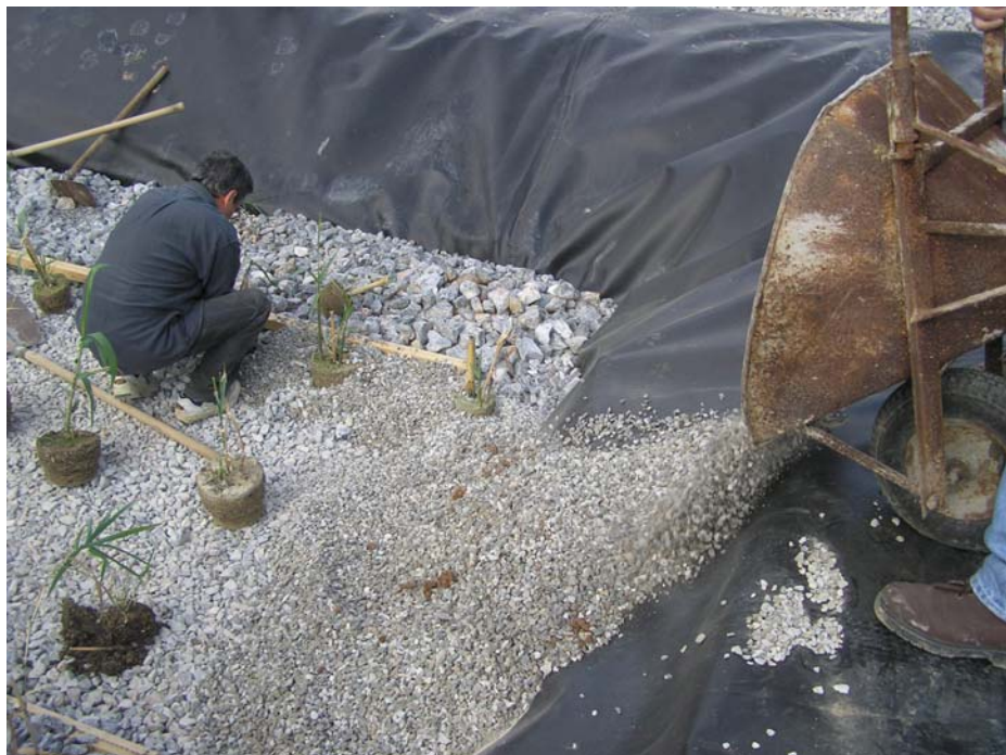
Φώτο 3.32 Φύτευση υγροβιότοπων υπό επιφανειακής ροής
