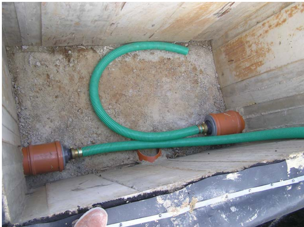
Φώτο 3.20 Ελεγχόμενη εκροή των υγροβιότοπων
