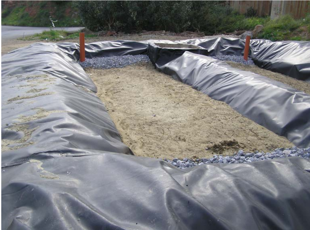
Φώτο 3.29 Ολοκλήρωση πλήρωσης υγροβιότοπων επιφανειακής ή ελεύθερης ροής
