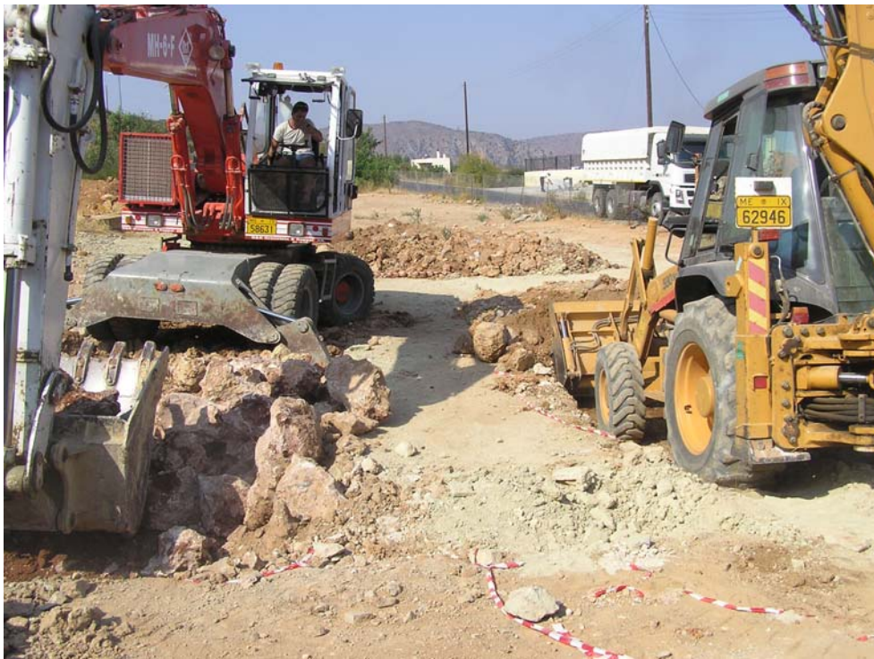
Φώτο 3.5 Μηχάνημα που χρησιμοποιήθηκαν κατά την εκσκαφή
