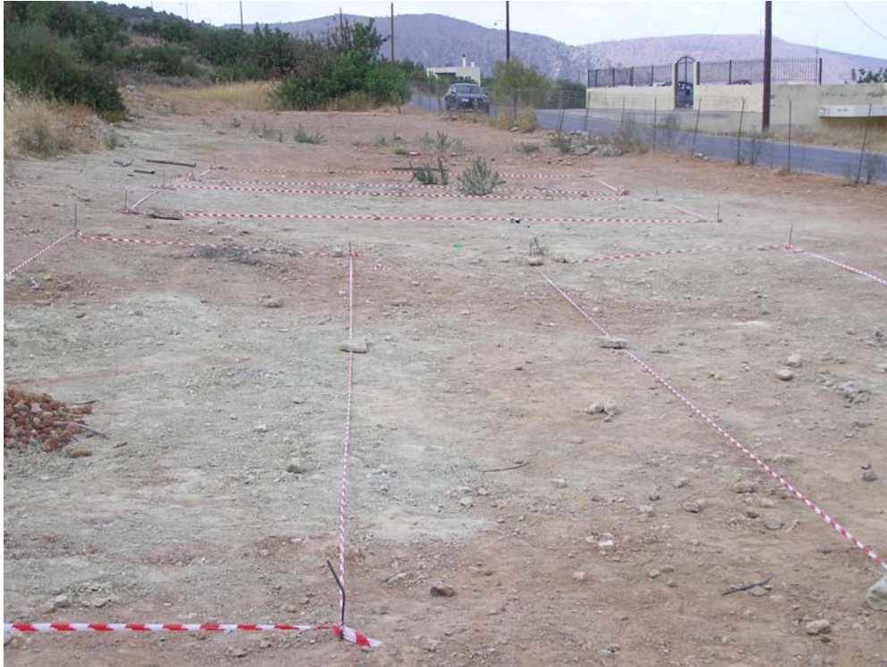
Φότο 3.4 Ολοκλήρωση διαδικασίας χάραξης
