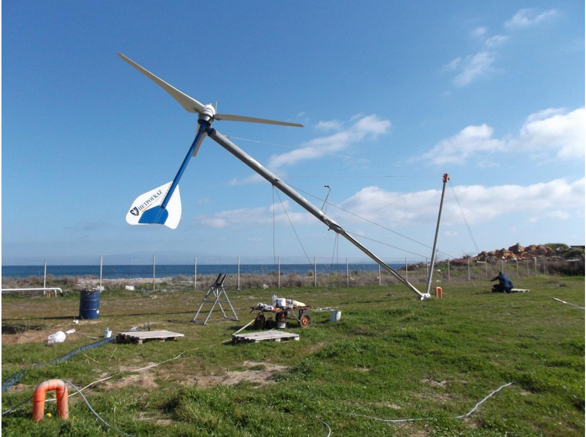
Εικόνα 8: Διαδικασία καθέλκυσης. Φαίνεται η βάση στήριξης του πλώνα στο έδαφος, καθώς επίσης και το σημείο που πιάνει στην κορυφή του πλώνα το επιπλέον συρματόσχοινο του μοχλοβραχίονα
