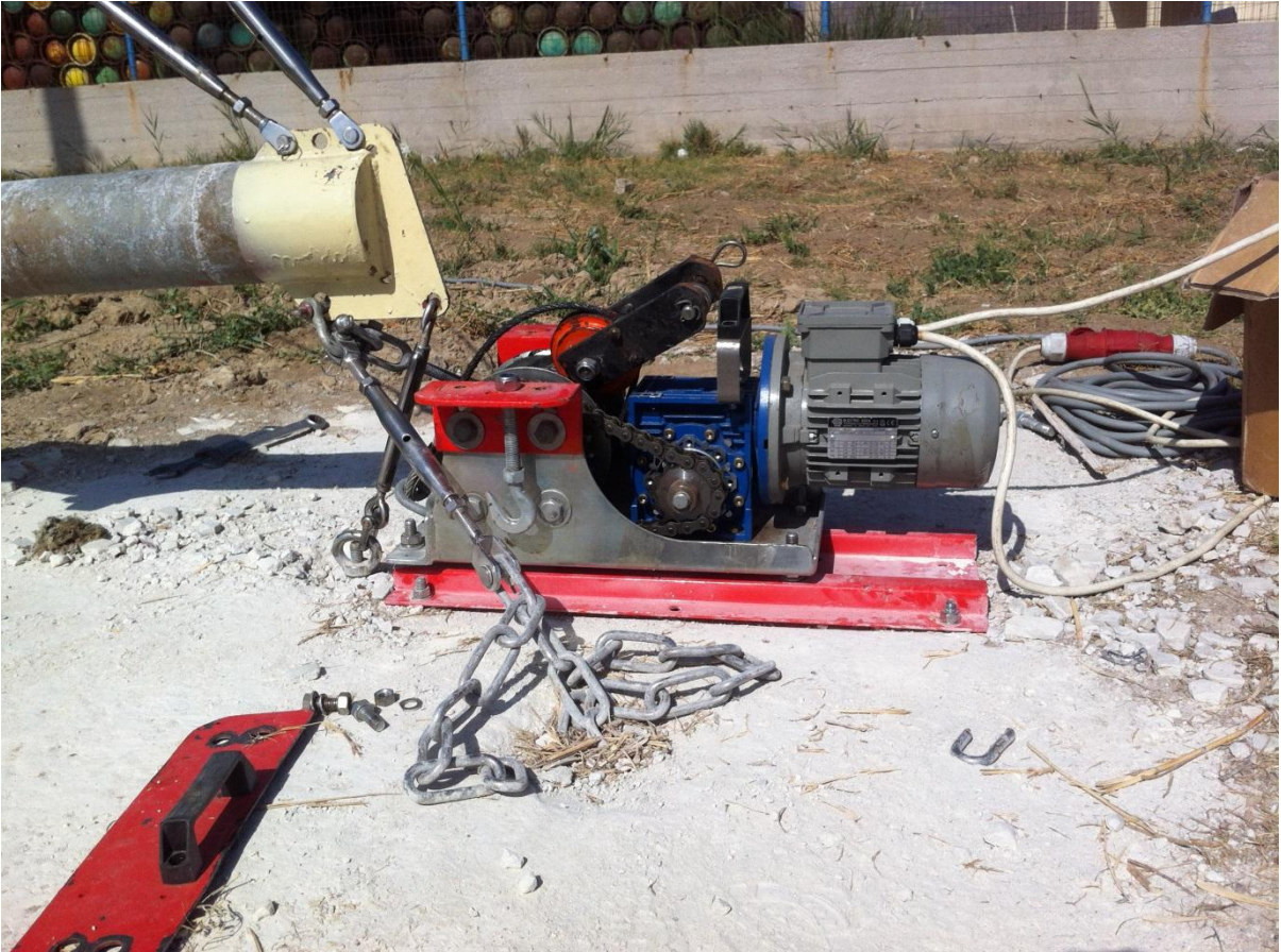
Εικόνα 7: Το βίντσι βιδωμένο στο έδαφος, έτοιμο να ενωθεί με το μοχλοβραχίονα.
