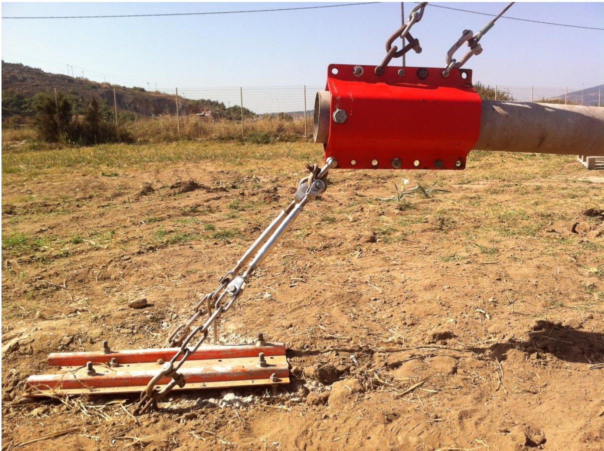
Εικόνα 10: Ο μοχλοβραχίονας έχει ασφαλιστεί με επιτυχία στις αντηρίδες.
