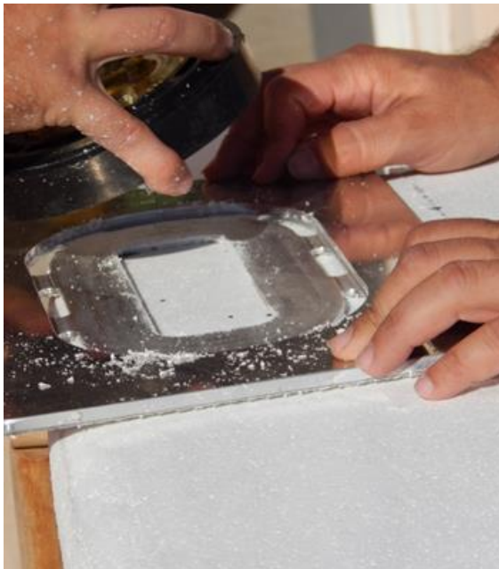
Εικόνα 22: σημάδεμα και προεργασία για τις οπές
