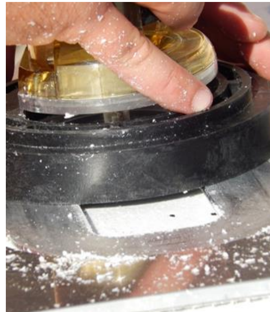
Εικόνα 22: σημάδεμα και προεργασία για τις οπές
