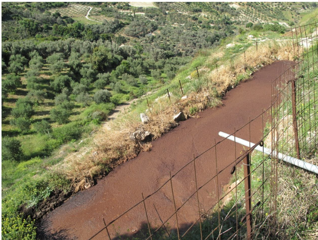
Εικόνα 26: Δεξαμενή αποβλήτων για ξήρανση.
