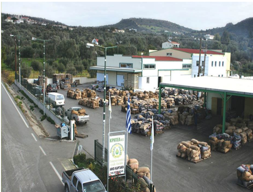
Εικόνα 17: Εργοστάσιο της CRETEL (από τα μεγαλύτερα στο νομό Ηρακλείου).
