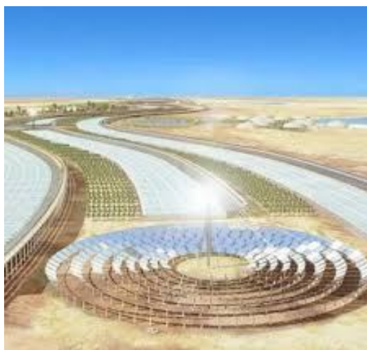
Εικόνα 2: Ηλιοθερμικό πάρκο παραγωγής ενέργειας με παραβολοειδούς συλλέκτες και πύργο συγκέντρωσης των ακτίνων.
