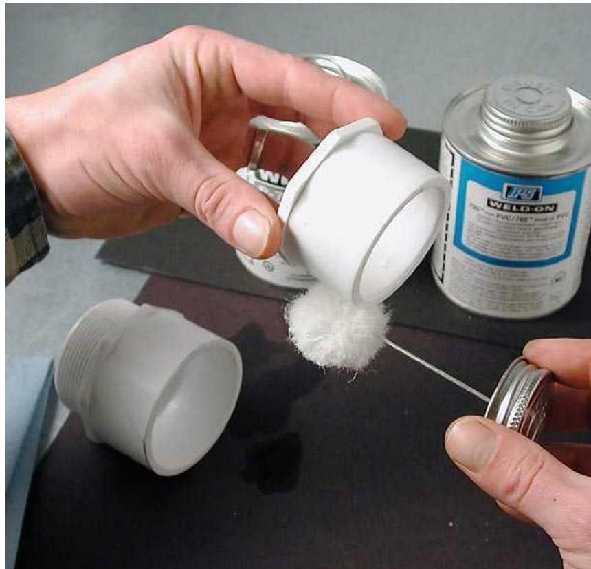
Εικόνα 9.1.2.1.1: Συγκόλληση με διαλύτες
