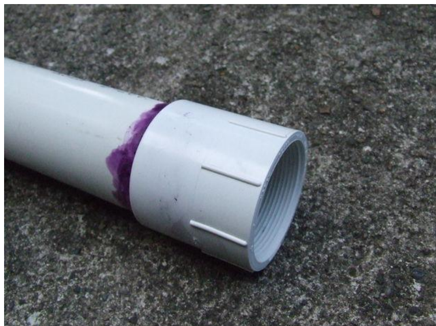
Εικόνα 9.1.2.1.1: Συγκόλληση με διαλύτες
