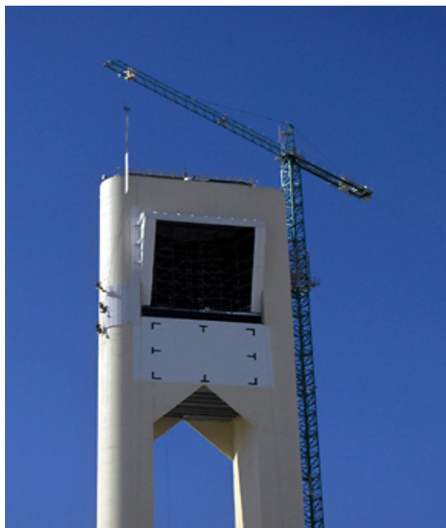
Εικόνα 3.6 Σωληνοειδής Εξωτερικός Δέκτης Κοιλότητας (Seville, Ισπανία) [31]
