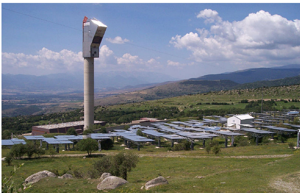
Εικόνα 4.2 THEMIS Solar Project (Γαλλία) [40]
