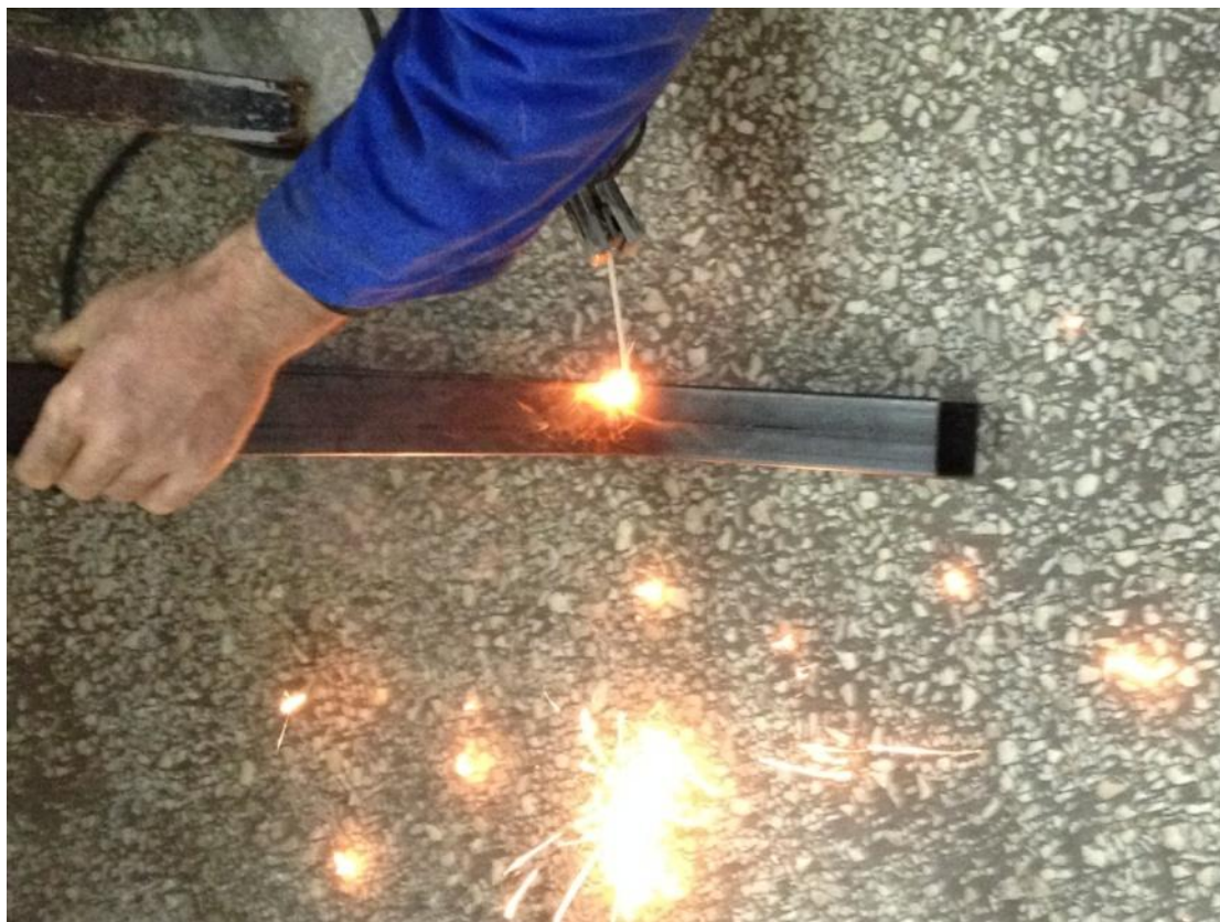
Εικόνα 10 Διαδικασία συγκόλλησης κοιλοδοκών με ηλεκτροσυγκόλληση.
