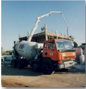
Κ. Κυθραιώτης Σκυρόδεμα Λτδ
