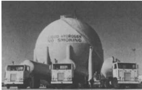
Εικόνα 8- Αποθηκευτής LH2 χωρητικότητας 3800m 3 στο διαστημικό κέντρο απογείωσης Kennedy στη Φλόριδα
