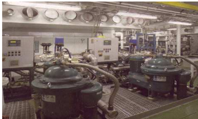
Εικόνα 2: Μηχανοστάσιο ενός πλοίου 1
