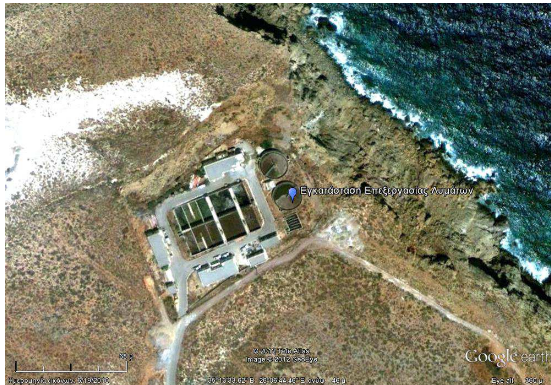
Εγκατάσταση επεξεργασίας λυμάτων Σητείας
