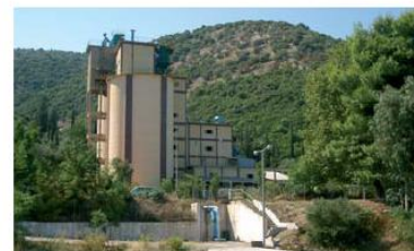
Έξι κέντρα διανομής τσιμέντου σε Θεσσαλονίκη, Δραπετσώνα, Ρίο, Ηράκλειο, Ηγουμενίτσα, Καβάλα που διακινούν 2,5 χιλιάδες τόνους τσιμέντο, το οποίο μεταφέρεται στους πελάτες μας σε όλη την Ελλάδα.
