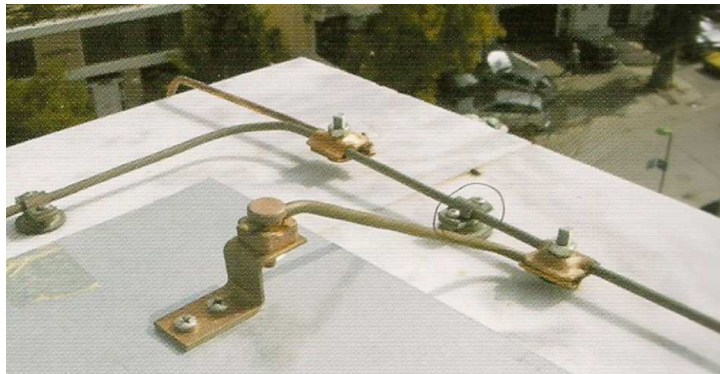
Εικόνα : Λεπτομέρεια γωνιακού ακροδέκτη.
