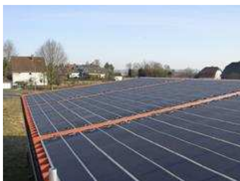
Τοποθέτηση ευλόγιστων Φ/Β σε στέγη
