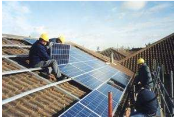
Τοποθέτηση Φ/Β σε στέγη παλαιού σπιτιού
