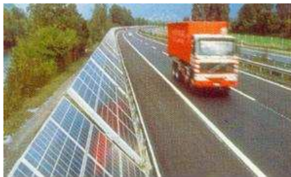
Φ/Β τοποθετημένα σε τοιχοπετάσματα δρόμων
