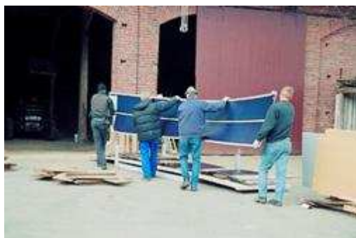
Τοποθέτηση ευλόγιστων Φ/Β σε στέγη Φ/Β σε στέγη
