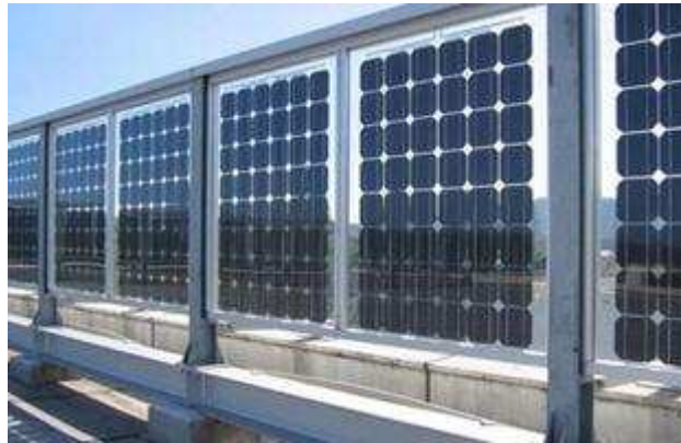
Φ/Β υαλοπίνακες τοποθετημένοι σε οροφή κτιρίου
