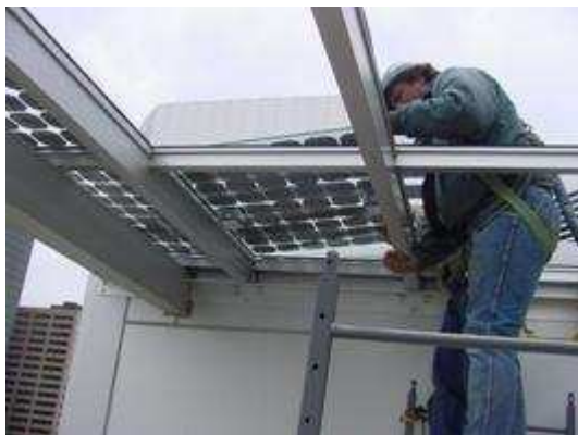
Φ/Β υαλοπίνακες κατά την τοποθέτηση σε οροφή κτιρίου
