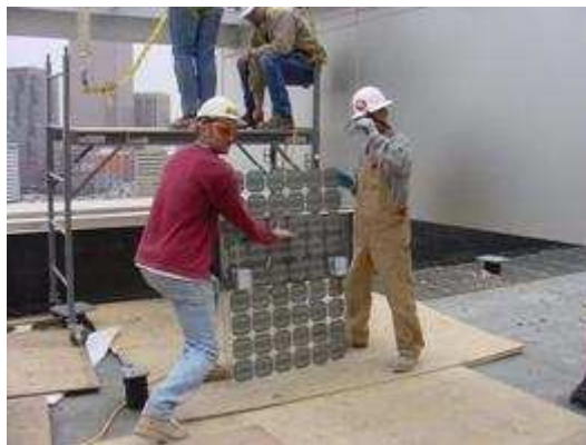
Φ/Β υαλοπίνακες κατά την τοποθέτηση σε οροφή κτιρίου
