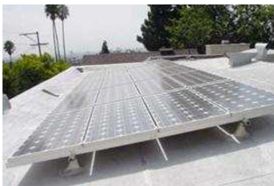
Τοποθέτηση των Φ/Β με χρήση αποστατών για τον σωστό αερισμό τους.
