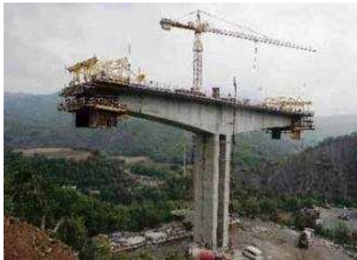
Εικόνα: Κατασκευή γέφυρας
