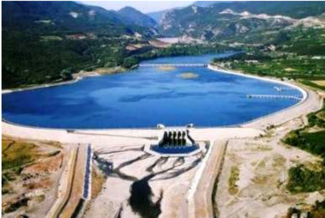
Εικόνα : Υδροηλεκτρικό φράγμα έργο του δήμου
