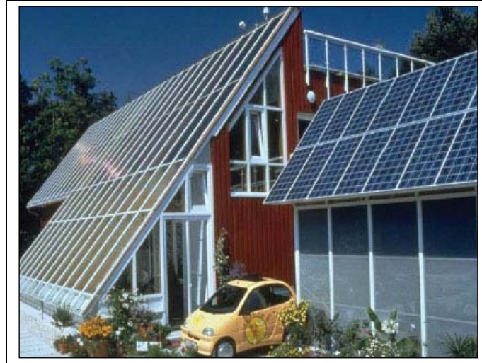
Εικ 3.8 Φωτοβολταϊκά σε φεγγίτες και παράθυρα (Πηγή: http://www.nirsepes.eu/docs/Tselepis.pdf )
