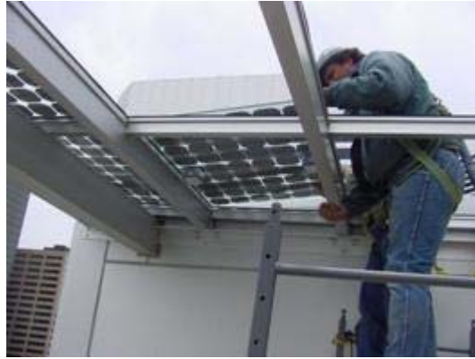
Εικ 4.11 Τοποθέτηση ενσωματωμένων Φ/Β
