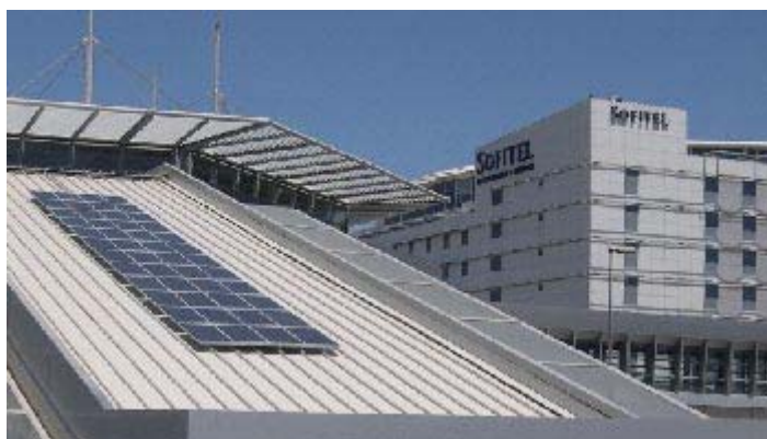
Εικ 5.8 Ενσωμάτωση Φ/Β στο σταθμό του μετρό στο αεροδρόμιο Ελευθέριος Βενιζέλος
