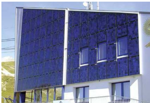
Εικ 4.9 Ενσωματωμένα Φ/Β σε πρόσοψη
