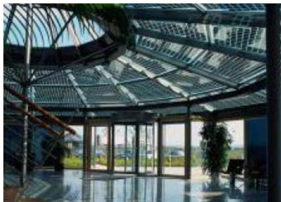
Εικ 3.11 Εφαρμογή Φωτοβολταϊκών σε Εμπορικό Κέντρο
