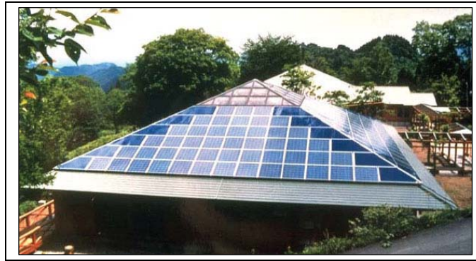
Εικ 3.14 Ενσωματωμένα Φ/Β στοιχεία σε κεκλιμένη στέγες
