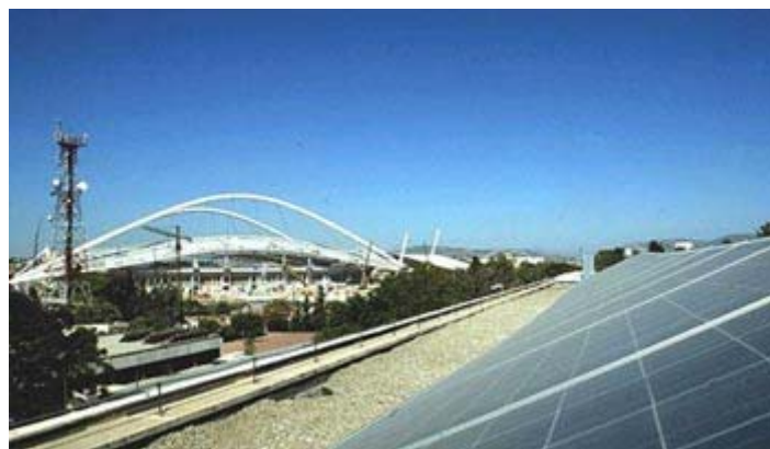
Εικ 5.10 Εφαρμογή Φ/Β στη στέγη της Γερμανικής Σχολής στο Μαρούσι
