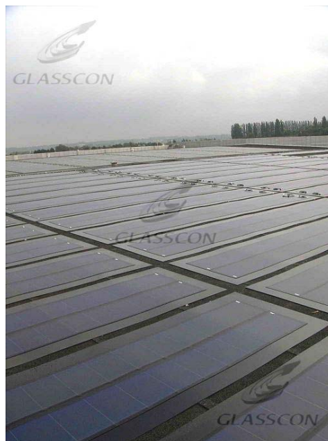
Εικ 4.7 Τοποθέτηση Φ/Β μεμβρανών σε δώμα
