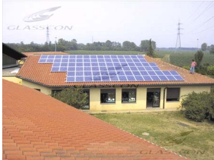
Εικ 4.4 Τοποθέτηση μη ενσωματωμένων Φ/Β σε κεραμοσκεπή
