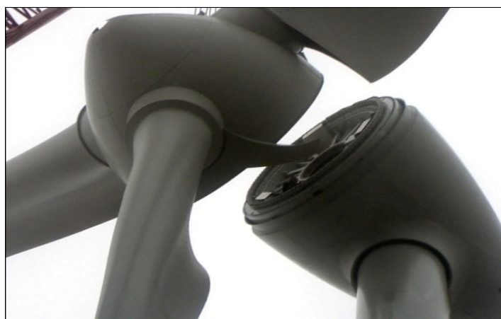
Εικόνα 2.3: Σύνδεση του δρομέα με την γεννήτρια.
