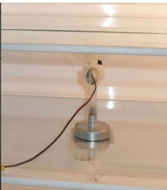
5. Θερμοζεύγος τοποθετημένο σε ειδικό στηριγματάκι
