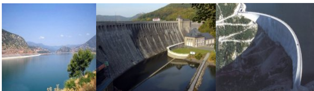
Εικόνα 7: Αριστερά: Γεωφράγμα Μόρνου, Μέση: Κτιστό βαρυντικό φράγμα, Δεξιά: Τοξωτό φράγμα
