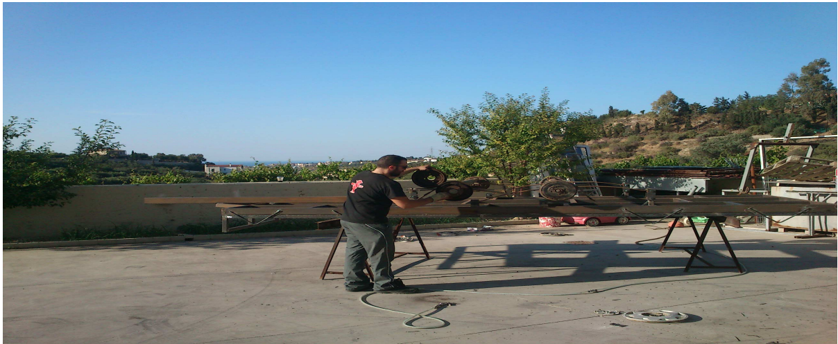
Εικόνα 90: ΚΑΛΟ ΚΑΘΑΡΙΣΜΑ ΤΡΕΙΛΕΡ ΜΕ ΑΕΡΑ ΚΑΙ ΚΑΘΑΡΙΣΤΙΚΟ ΜΕΤΑΛΛΩΝ ΓΙΑ ΑΠΟΜΑΚΡΥΝΣΗ ΛΑΔΙΩΝ Η ΤΥΧΩΝ ΑΚΑΘΑΡΣΙΩΝ ΑΠΟ ΤΗ ΚΑΤΑΣΚΕΥΗ ΜΑΣ.
