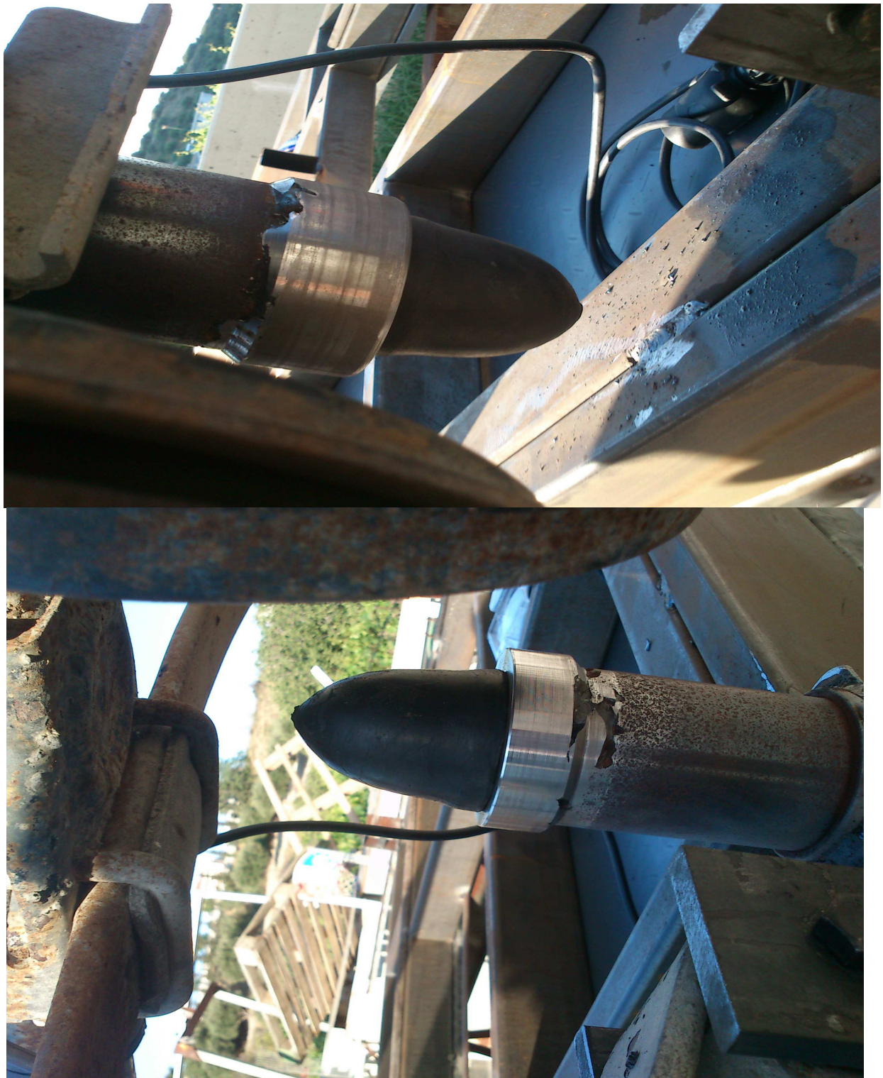
Εικόνα 67:ΕΓΚΑΤΑΣΤΑΣΗ ΚΑΙ ΣΥΓΚΟΛΛΗΣΗ ΣΤΟΠ ΑΝΑΡΤΗΣΕΩΣ.
