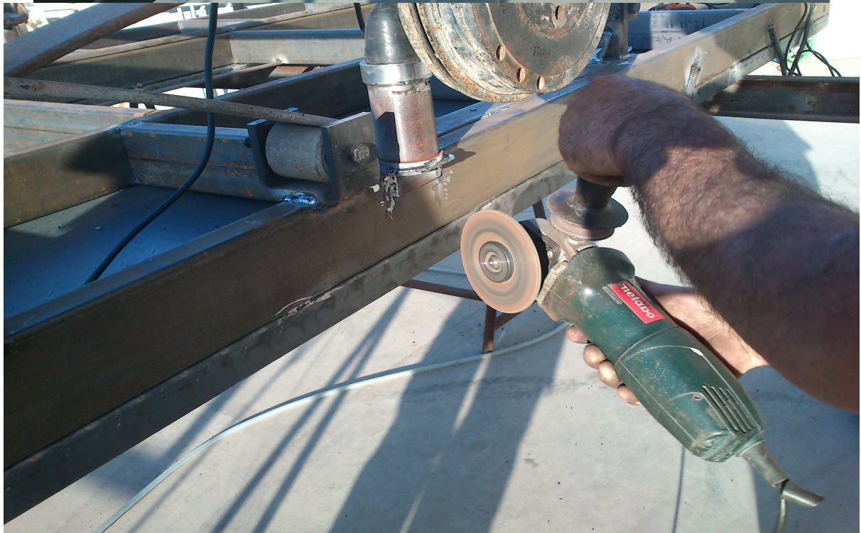
Εικόνα 69:ΕΓΚΑΤΑΣΤΑΣΗ ΚΑΙ ΤΡΟΧΙΣΜΑ ΣΥΓΚΟΛΜΗΣΗΣ ΣΤΟΠ ΑΝΑΡΤΗΣΕΩΣ.
