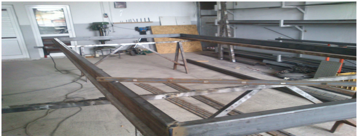
Εικόνα 29:ΣΥΝΑΡΜΟΛΟΓΗΣΗ ΠΛΑΙΣΙΟΥ
