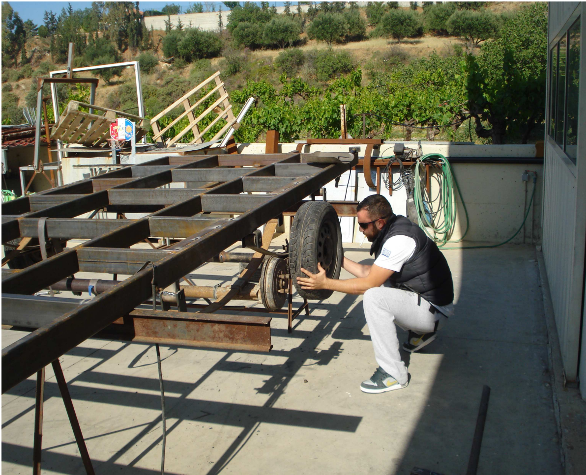
Εικόνα 72:ΕΓΚΑΤΑΣΤΑΣΗ ΚΑΙ ΤΟΠΟΘΕΤΗΣΗ ΕΛΑΣΤΙΚΩΝ ΣΤΑ ΑΚΡΑ.
