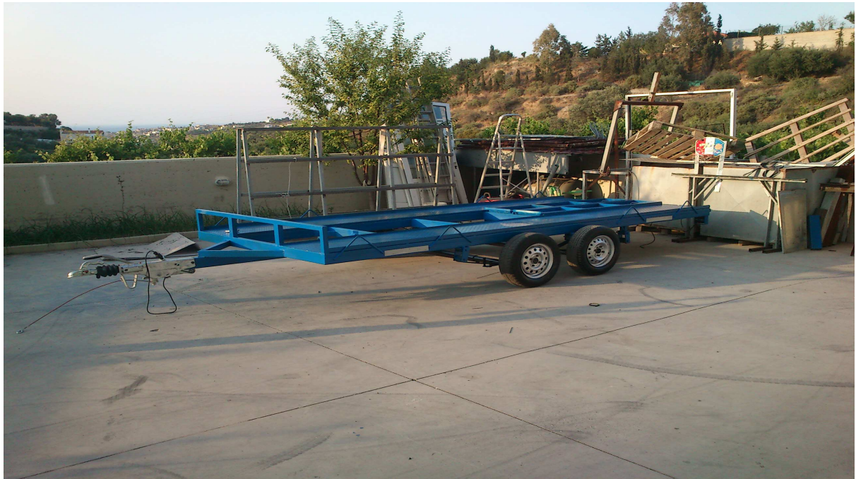
Εικόνα 104: ΣΥΝΔΕΣΗ ΚΑΙ ΕΛΕΓΧΟΣ ΗΛΕΚΤΡΟΛΟΓΙΚΩΝ ΤΟΠΟΘΕΤΗΣΗ ΑΝΑΚΛΑΣΤΗΡΩΝ.
