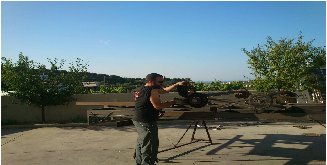
Εικόνα 89: ΤΡΙΨΙΜΟ ΤΑΜΠΟΥΡΩΝ, ΚΑΛΟ ΚΑΘΑΡΙΣΜΑ.
