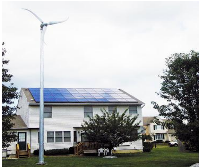
Σχήμα 5.2: Ανεμογεννήτρια Τοποθετημένη σε Εξωτερικό Χώρο Κατοικίας
