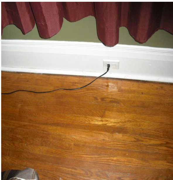
Εικόνα 29: Διαρροή ρεύμα αέρα από το φως
