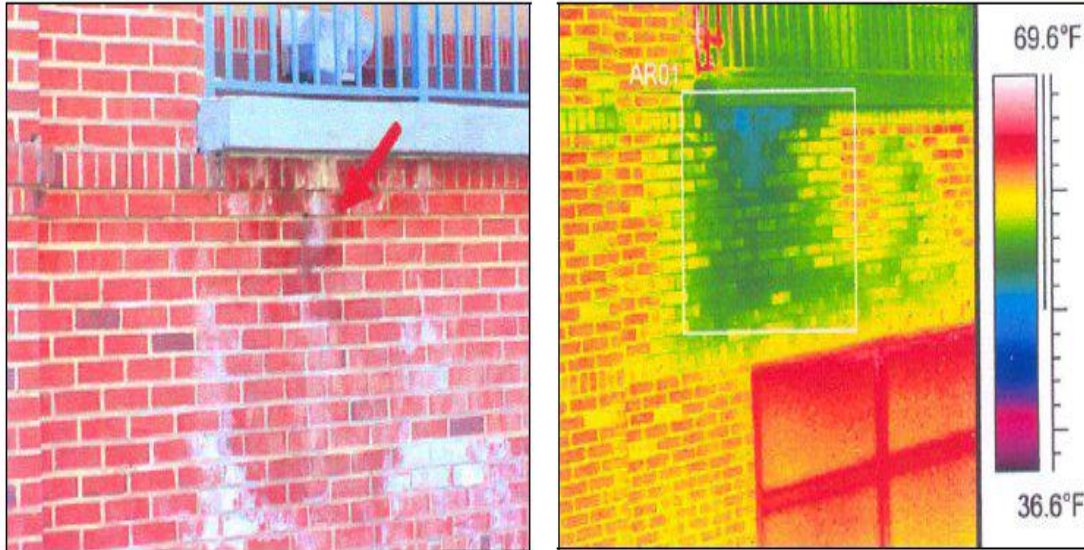
Εικόνα 27: Διείσδυση υγρασίας
