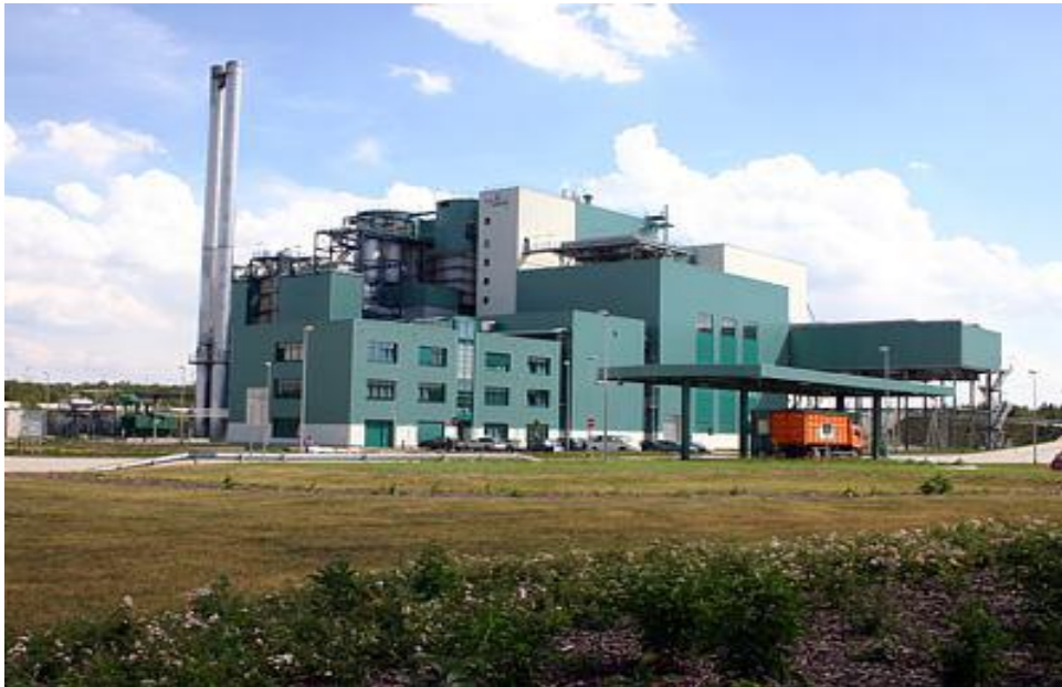
Εικόνα 2: Μονάδα αποτέφρωσης Α.Σ.Α. στη Γερμανία
