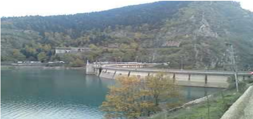
Εικόνα 58 : Υδροηλεκτρικό φράγμα στη λίμνη Πλαστήρα.
