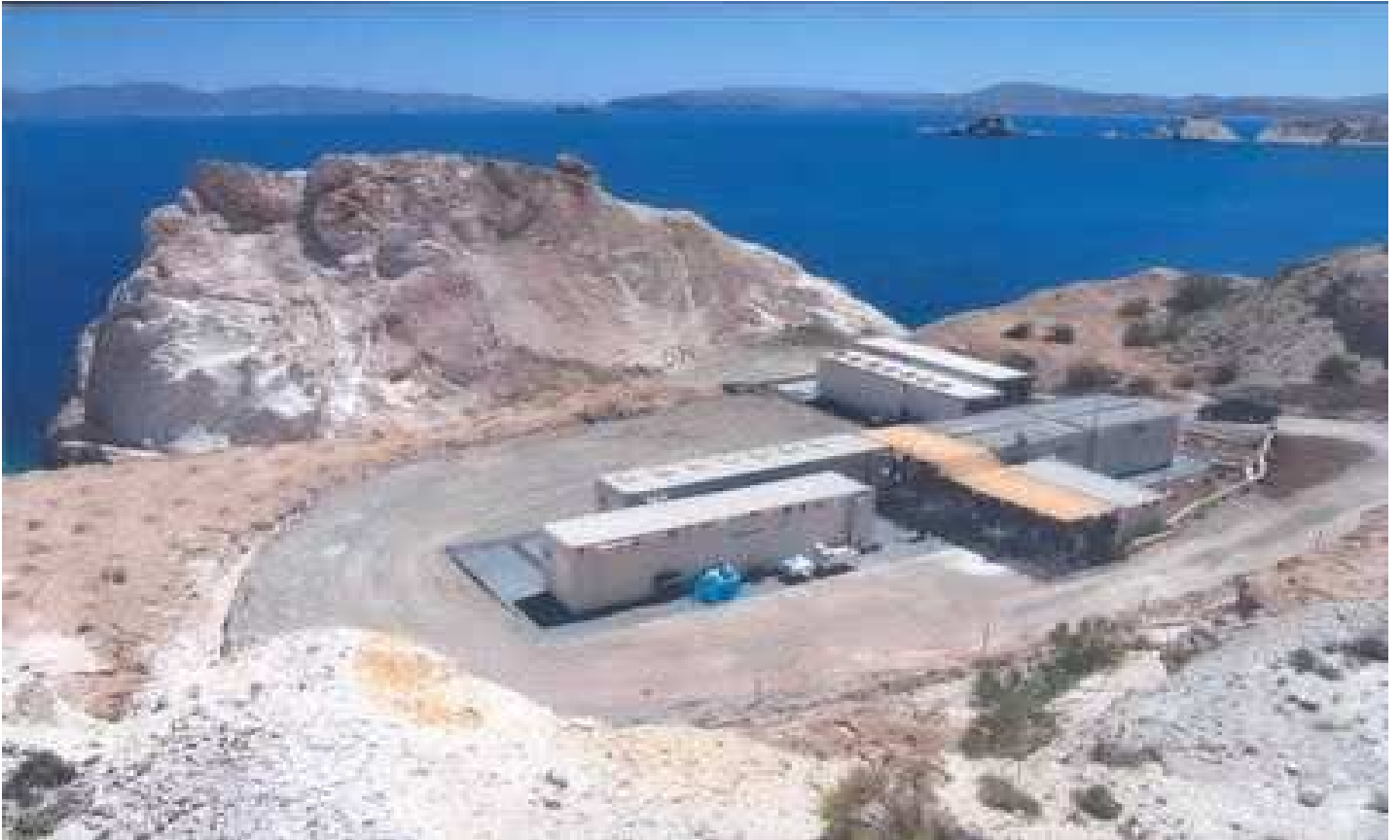
Εικόνα 43: Μονάδα αφαλάτωσης στη Μηλο
