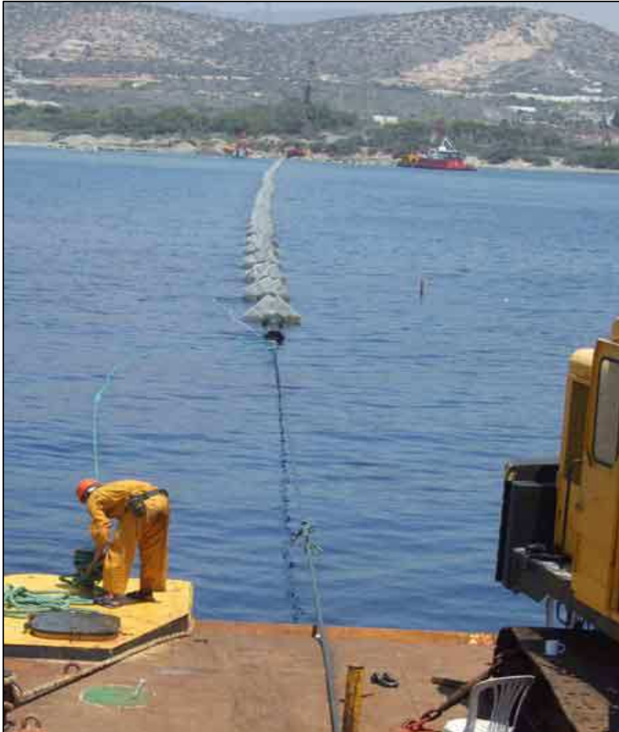
Εικόνα 74 : Τοποθέτηση αγωγού απόρριψης άλμης, Κύπρος
