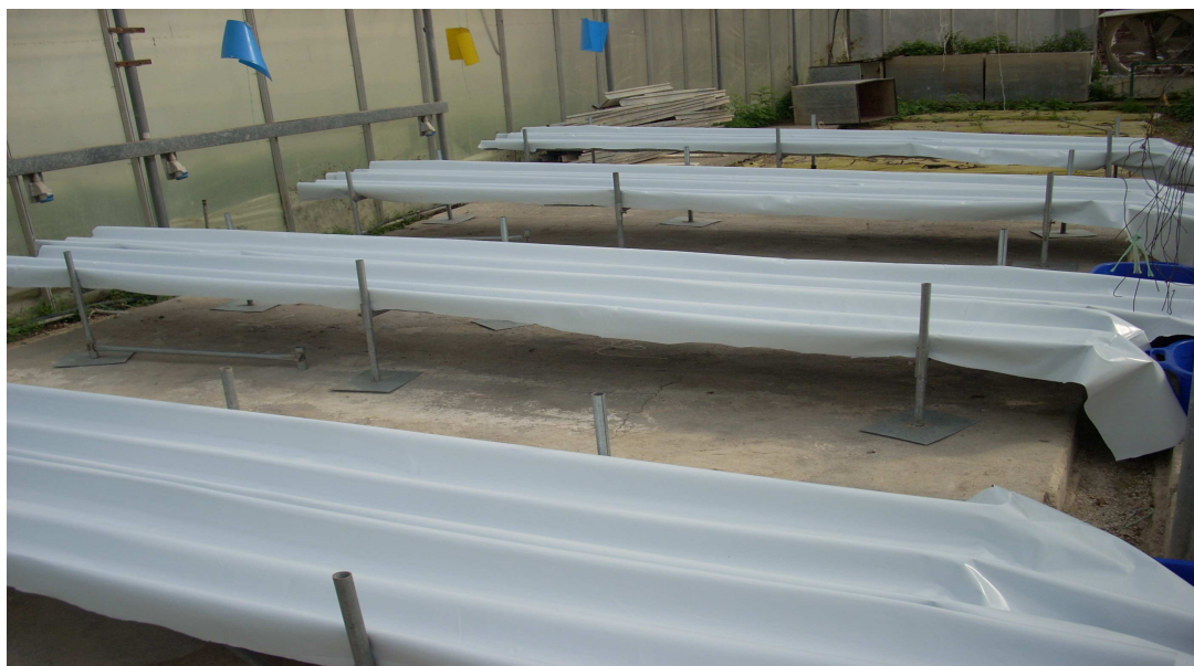
Εικόνα 4.2. Τοποθέτηση της λευκής όψης του πλαστικού νάιλον στην βάση της λαμαρίνας.
