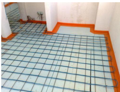
Εικ.7:19: Εγκατάσταση θερμικών καλωδίων σε δάπεδο.
