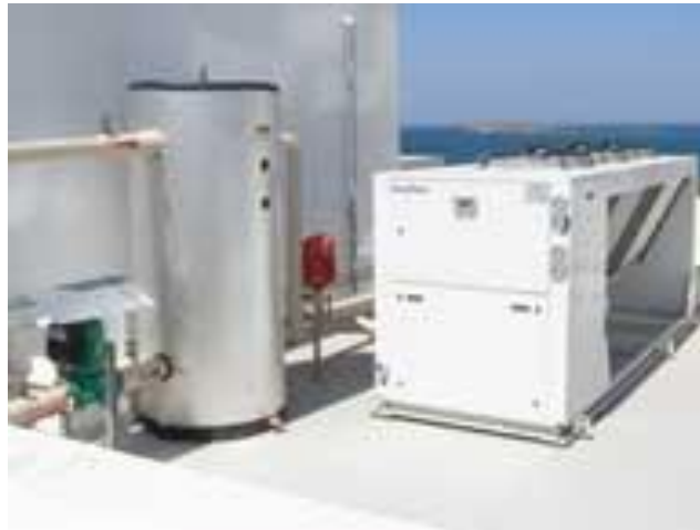
Εικ. 6.2: Δοχείο αδρανείας σε εγκαταστάσεις ψύξης.
