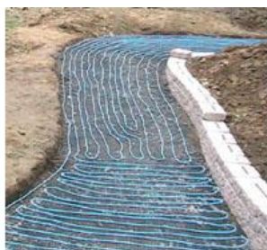
Εικ. 7:15: Θερμικά καλώδια εδάφους.
