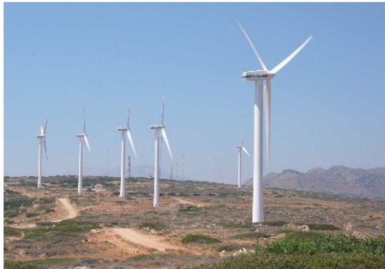
Εικόνα 1.25: Χερσαίο Αιολικό Πάρκο στην Κρήτη.
