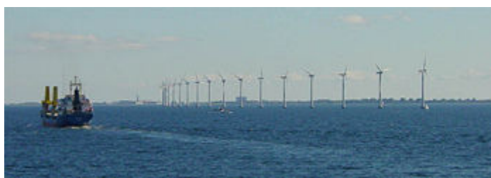
Εικόνα 1.27: Θαλάσσιο Αιολικό Πάρκο κοντά στην Κοπεγχάγη.
