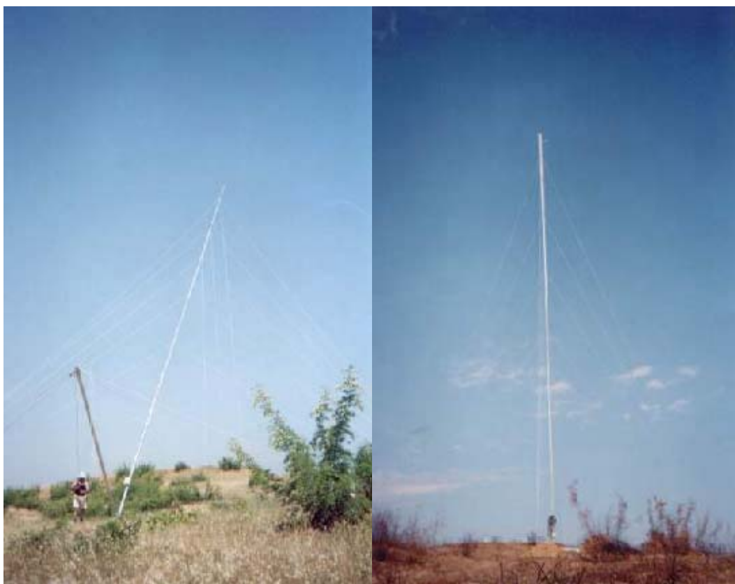
Σχήμα 3.2 Διαδικασία ανέγερσης ενός μετεωρολογικού ιστού
