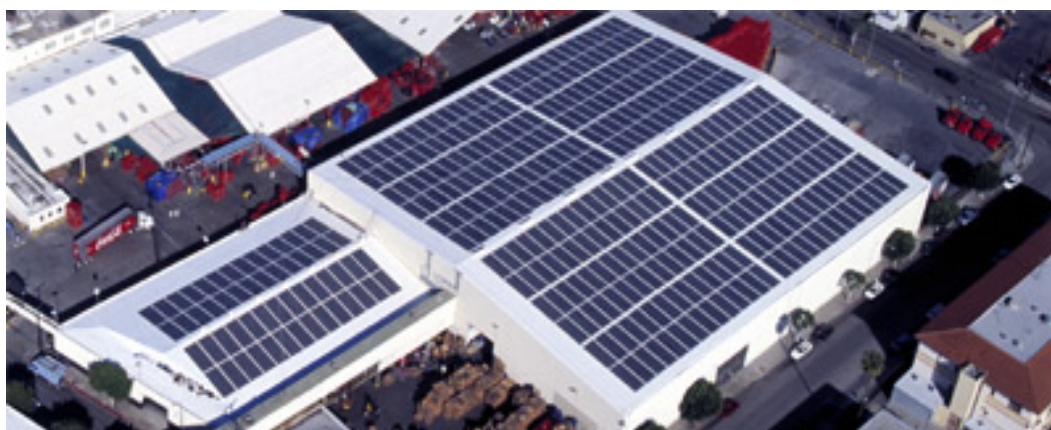
Εικόνα 20. Φωτοβολταϊκά στη στέγη βιομηχανικής μονάδας.
