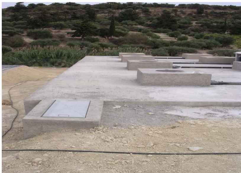
Εικόνα 2. Όψη του φρεατίου εισόδου και τμήματος της σηπτικής δεξαμενής
