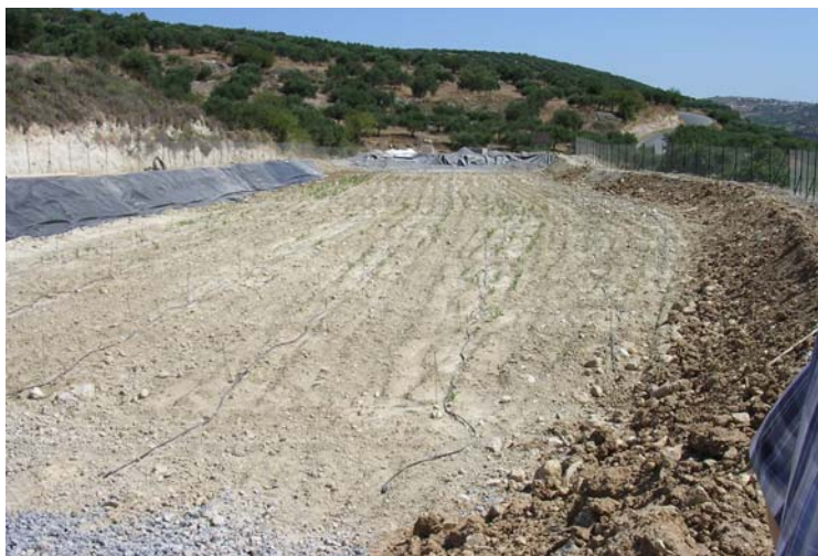
Εικόνα 11. Όψη τεχνητού υγροβιοτόπου πριν από τη φύτευση
