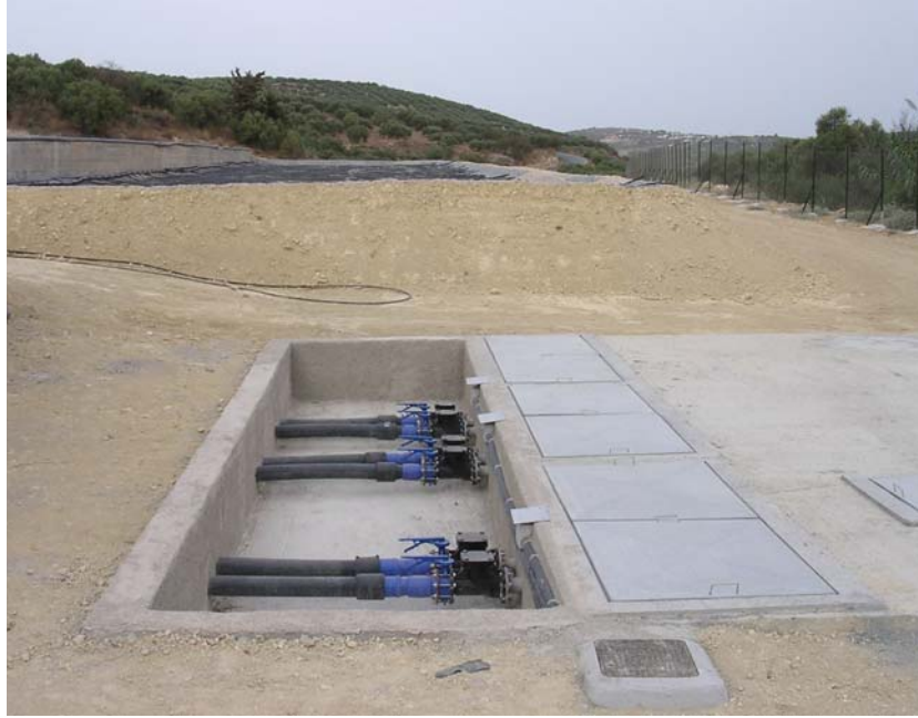
Εικόνα 7. Αντλίες τροφοδοσίας βιολογικού αμμόφιλτρου
