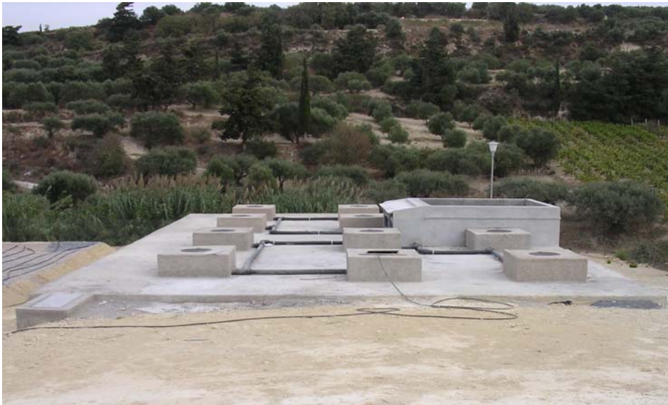
Εικόνα 3. Όψη σηπτικής δεξαμενής
