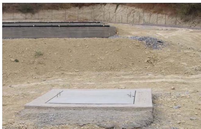
Εικόνα 9. Φρεάτιο τροφοδοσίας και τμήμα λεκάνης τεχνητού υγροβιοτόπου
