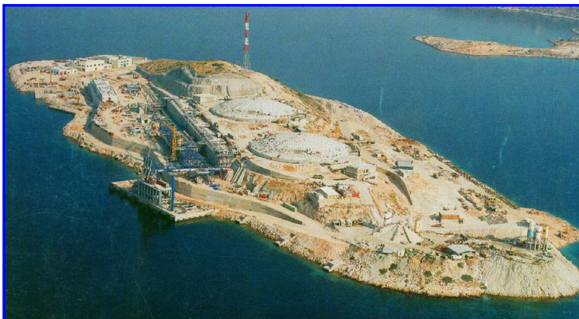
Εικ. 2-9 Πανοραμική άποψη εγκαταστάσεων υποδοχής Υ.Φ.Α. νήσου Ρεβυθούσας
