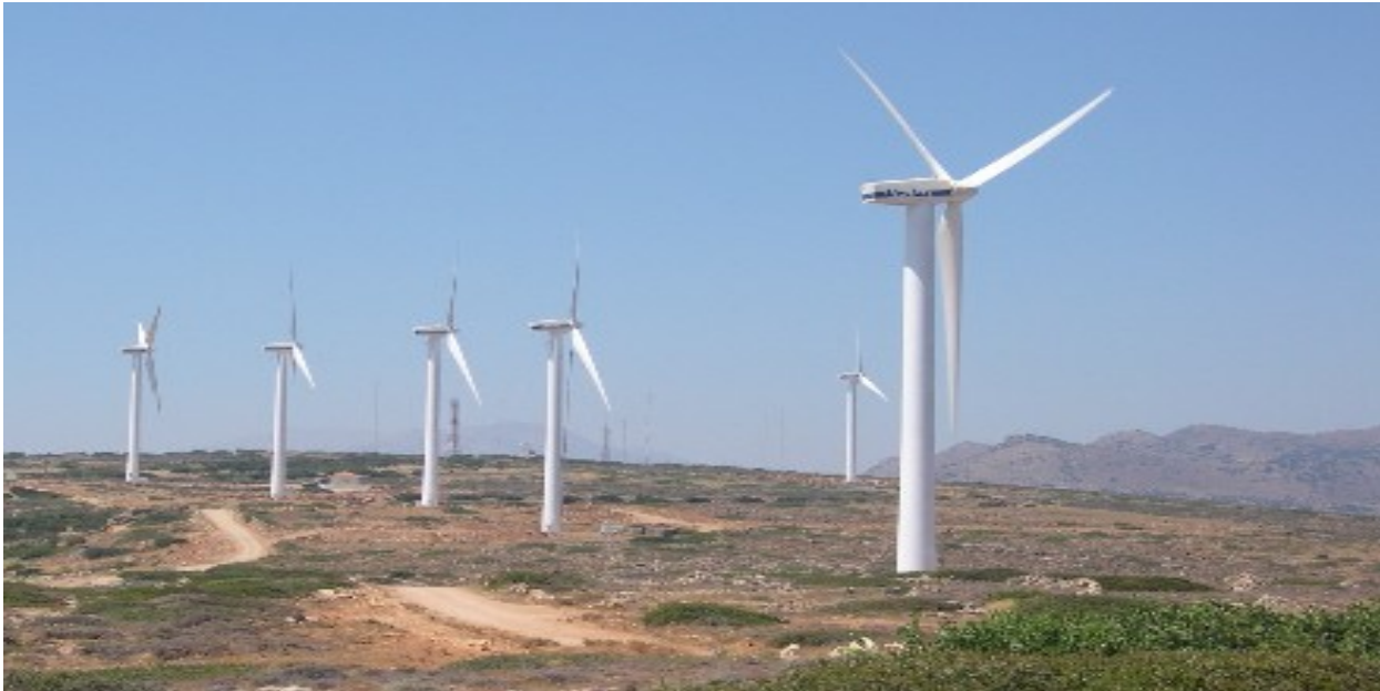
Εικόνα 3.2 Αιολικό Πάρκο στον Άη Γιάννη Βρουχά στη Σητεία Λασιθίου
