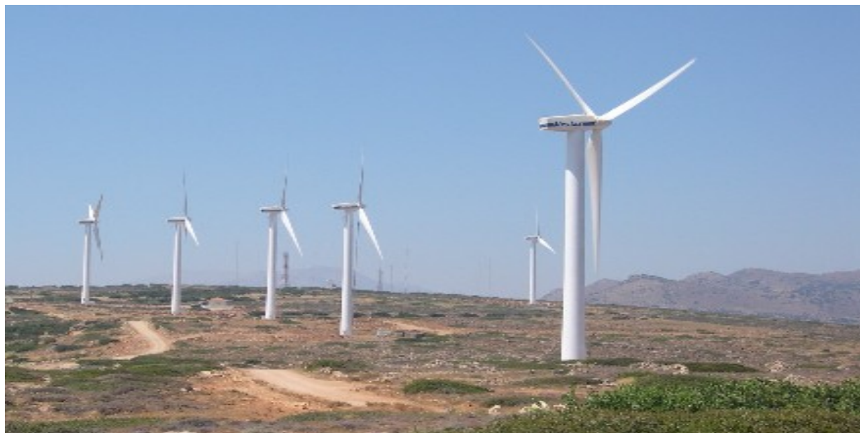
Εικόνα 3.1 Αιολικό Πάρκο στον Άη Γιάννη Βρουχά στη Σητεία Λασιθίου
