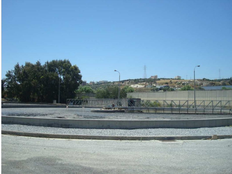
Εικόνα 1. Δεξαμενή πρωτοβάθμιας καθίζησης.
