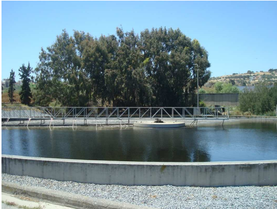
Εικόνα 2. Δεξαμενή δευτεροβάθμιας καθίζησης.
