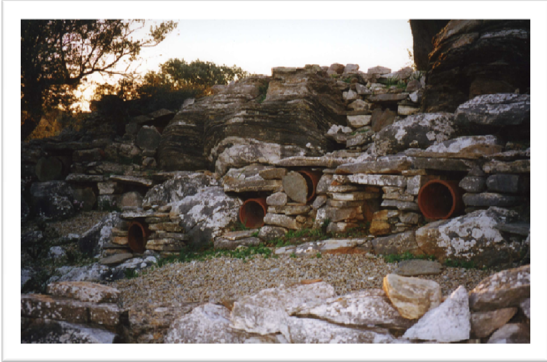
Εικόνα 3. Πήλινα οριζόντια υψέλια τοποθετημένα σε θυρίδες φτιαγμένες από πετρό-πλακες σε τράφους (πεζούλια ή αναβαθμίδες), στη περιοχή Μέλανες Νάξου.
