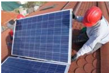
Εικόνα 3 : Εγκατάσταση οικιακών Φ/Β συστημάτων
