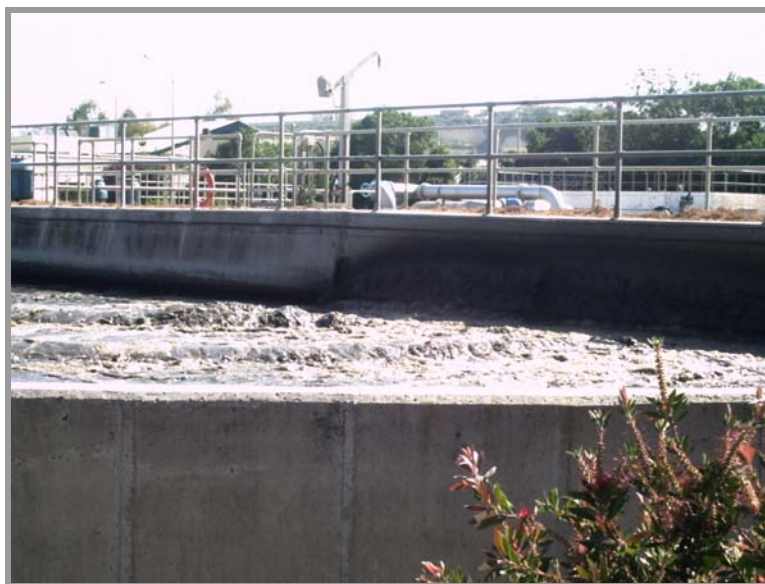
Εικόνα2.6 Δεξαμενή αερισμού Βιολογικού καθαρισμού Ηρακλείου
