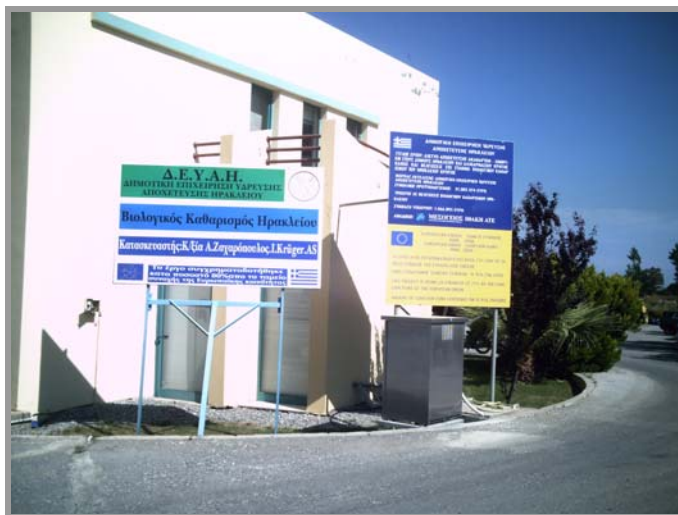
Εικόνα2.1 Είσοδος Βιολογικού καθαρισμού Ηρακλείου
