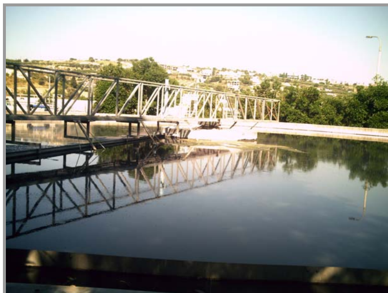
Εικόνα2.5 Δεξαμενή πρωτοβάθμιας καθίζησης Βιολογικού καθαρισμού Ηρακλείου
