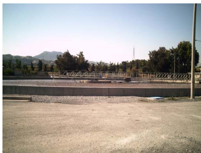
Εικόνα2.7 Δεξαμενή δευτεροβάθμιας καθίζησης Βιολογικού καθαρισμού Ηρακλείου
