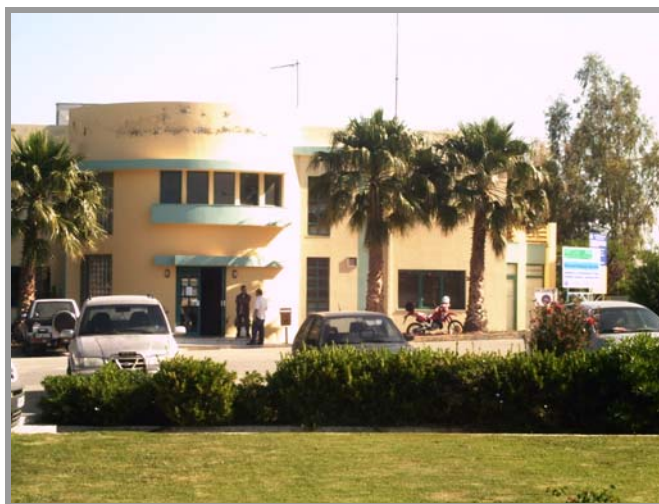
Εικόνα2.2 Κτήριο διοίκησης Βιολογικού καθαρισμού Ηρακλείου
