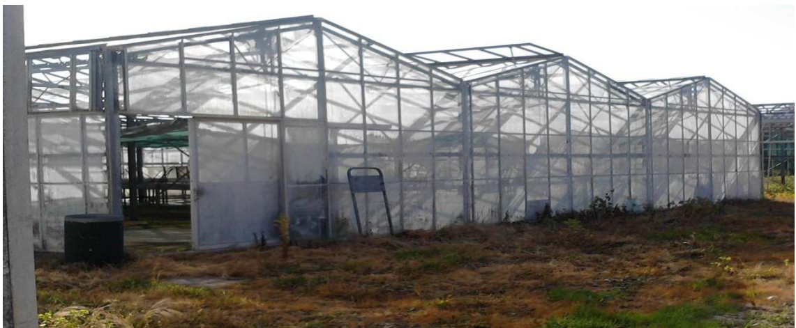
Εικόνα 19.Θερμοκήπιο,αγρόκτημα, εργαστηρίου γεωργίας και παραγωγής πολλαπλασιαστικού υλικού ΤΕΙ Ηρακλείου.
