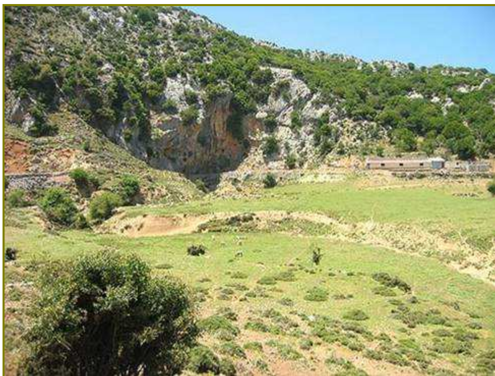
Εικόνα 3 Αποστραγγιστικό έργο (Χώνος)
