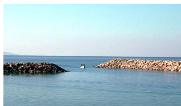
Εικόνα 17 - Λιμάνι Κόκκινου Πύργου
