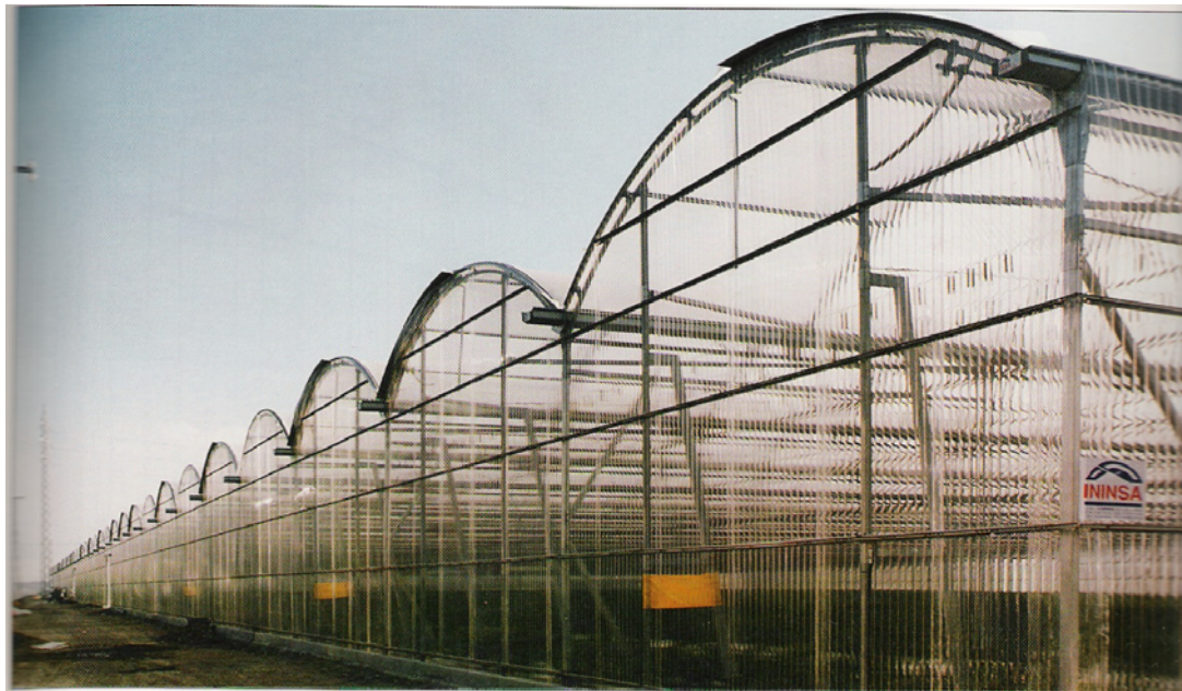
Εικόνα 6 : Τροποποιημένο τοξωτό θερμοκήπιο ισπανικής κατασκευής καλυμμένο με σκληρό πλαστικό (Polycarbonate)
