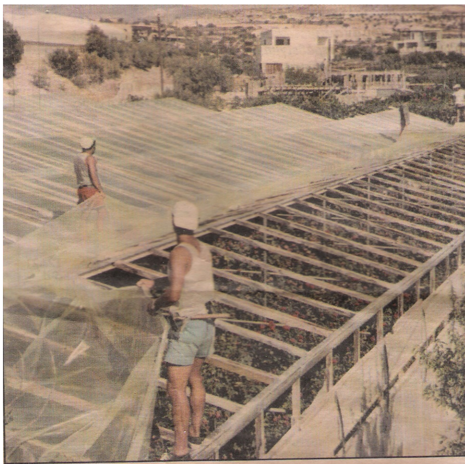
Εικόνα 10 : Τοποθέτηση πολυαιθυλενίου σε ξύλινο θερμοκήπιο στην περιοχή της Ιεράπετρας Κρήτης
