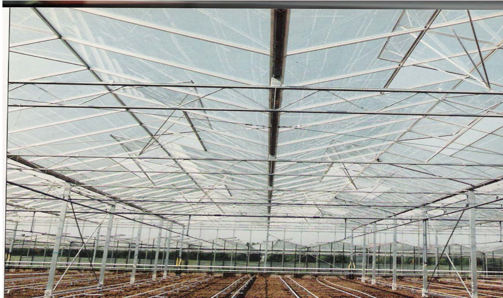
Εικόνα 5 : Γυάλινο θερμοκήπιο τύπου Venlo με οροφή από προφίλ αλουμινίου
