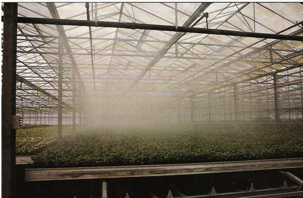
Εικόνα 3 : Οι πολύ λεπτές σταγόνες που δημιουργεί το σύστημα ομίχλης μειώνουν την θερμοκρασία κατά 5 – 14°C
