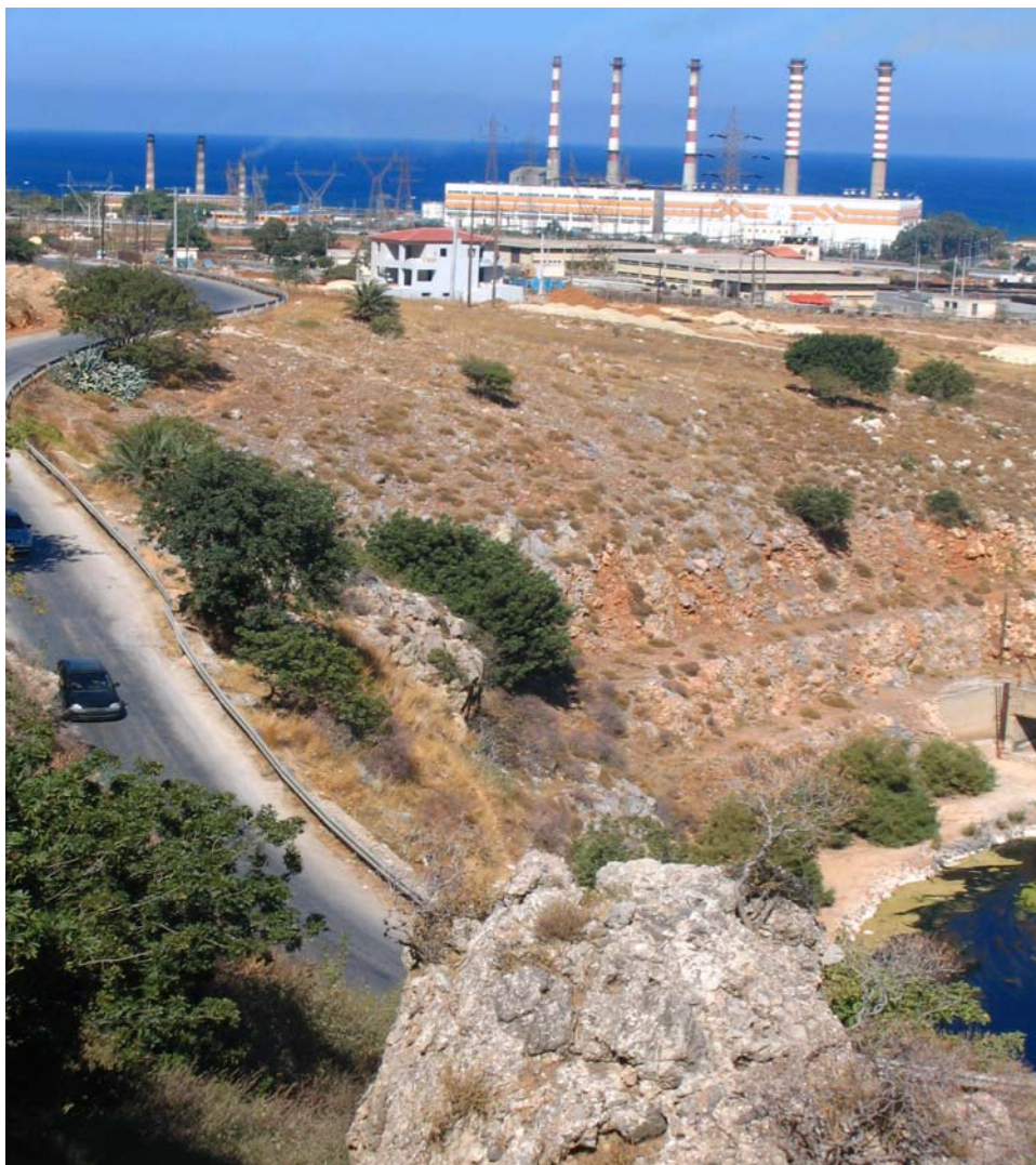
Εικόνα 5: Εγκαταστάσεις της Δ.Ε.Η.
