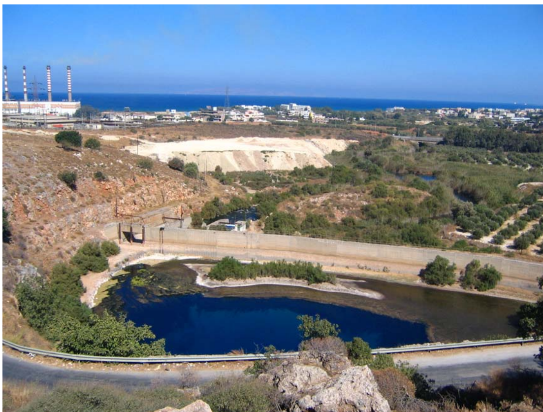
Εικόνα 1: Φράγμα του Αλμυρού ποταμού
