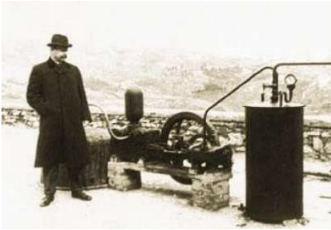
Σχήμα 4: Η μηχανή που χρησιμοποιήθηκε στο Larderello το 1904 κατά την πρώτη πειραματική απόπειρα παραγωγής ηλεκτρικής ενέργειας από γεωθερμικό ατμό. Διακρίνεται επίσης ο εφευρέτης της, πρίγκηπας Piero Ginori Conti. .
