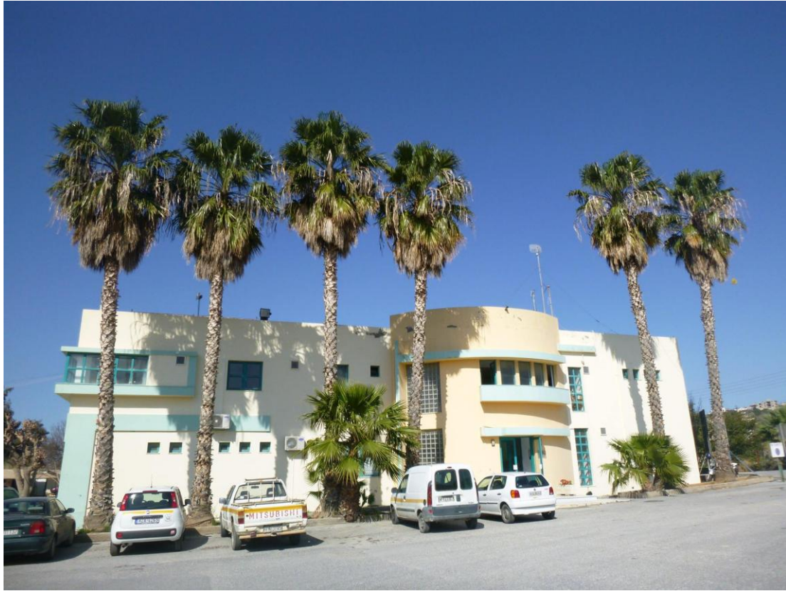
Σχήμα 36: Κτίριο διοίκησης βιολογικό καθαρισμός Ηράκλειο Κρήτης, ΔΕΥΑΗ.
