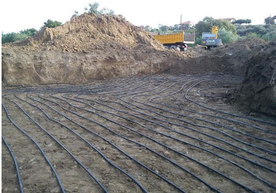
Σχήμα 28: Γεωεναλλάκτης κλειστός οριζόντιο σύστημα.
