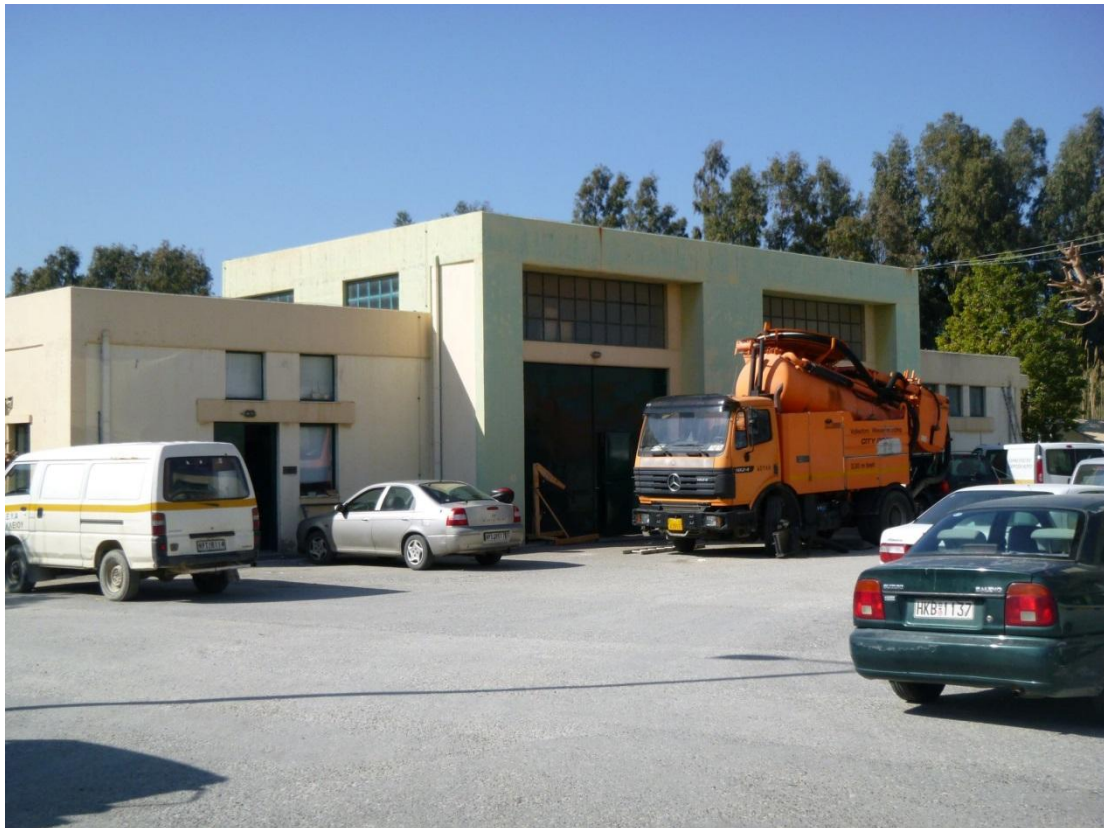
Σχήμα 37: Κτίριο συνεργείο βιολογικό καθαρισμός Ηράκλειο Κρήτης, ΔΕΥΑΗ.
