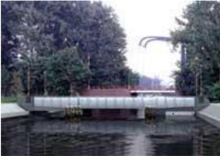
Εικόνα 48 Αλουμινένια γέφυρα στο Χέλμοντ της Ολλανδίας
