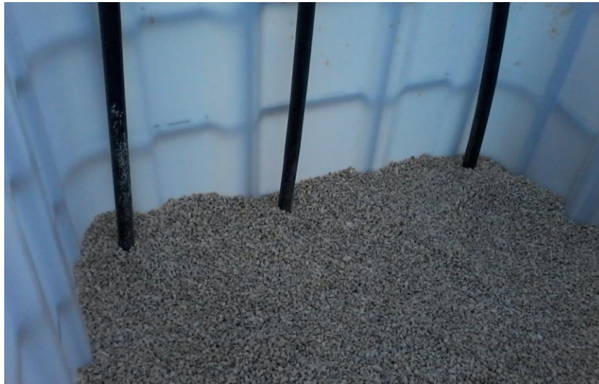
Εικόνα 18. Υλικά πλήρωσης τεχνητού υγροβιότοπου κατακόρυφης ροής
